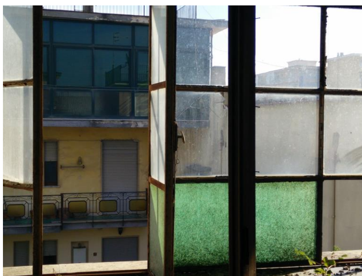
Foto n. 46 – Particolare vetrata veranda
