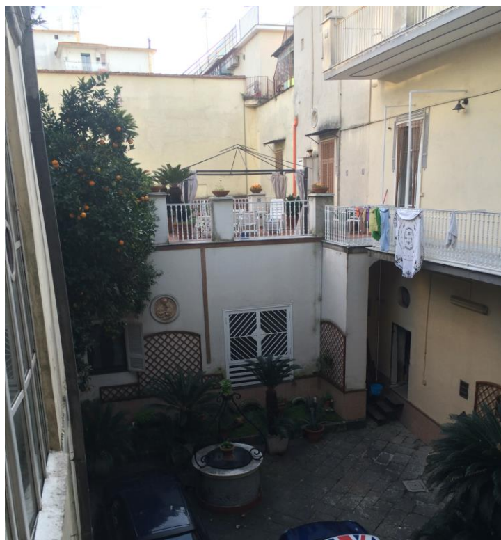
Foto n. 5 – Cortile interno con posti auto
