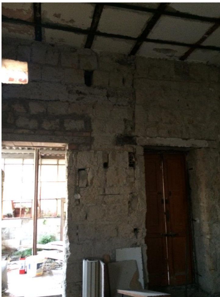
Foto n. 49 – Accesso alla veranda dall'immobile
