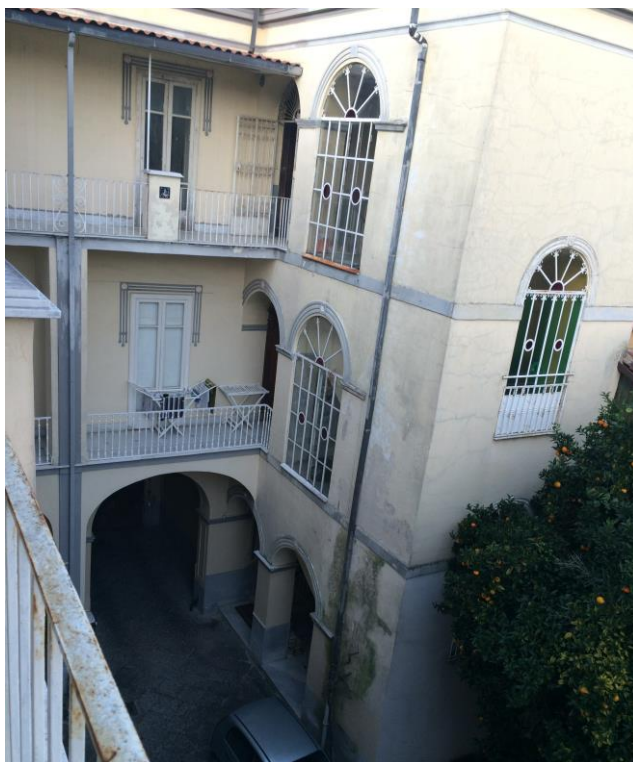
Foto n. 9 – Vista del cortile e del corpo scala
