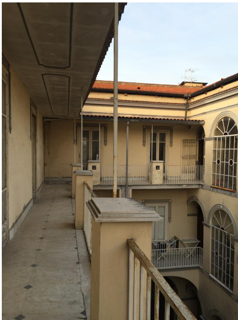
Foto n. . 33 – Vista del ballatoio
