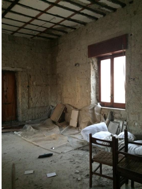
Foto n. 21 – Vista 2) area sottoposta a ristrutturazione
