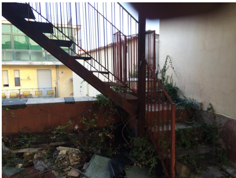
Foto n. 27 – Scala in ferro sul terrazzino
