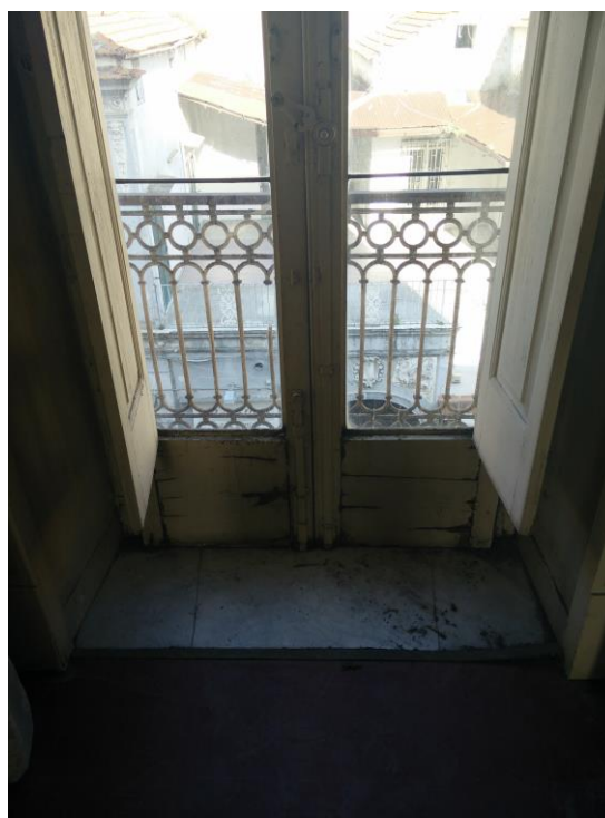
Foto n. 31 – Vista interna affaccio
