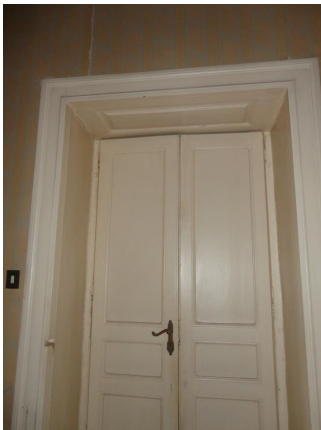
Foto n. 42 – Particolare infisso interno
