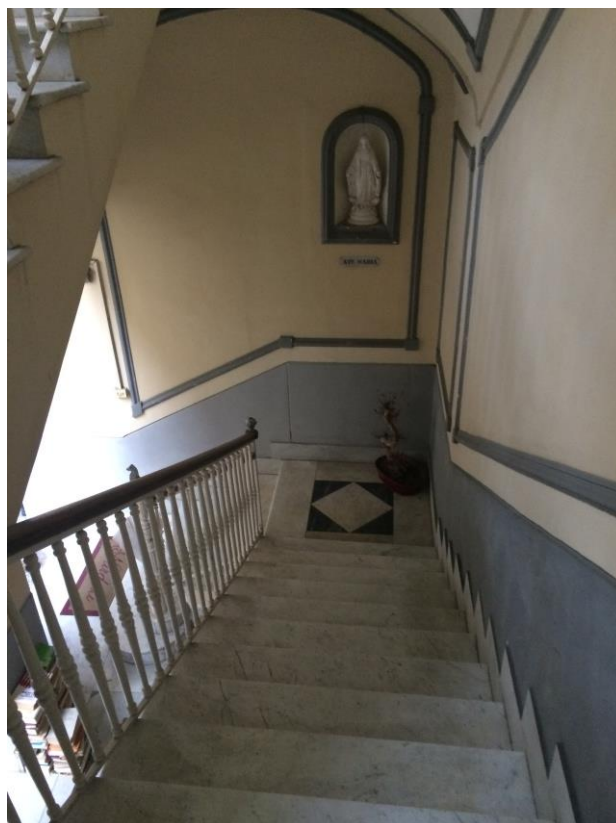
Foto n. 7 – Vista 1) corpo scala
