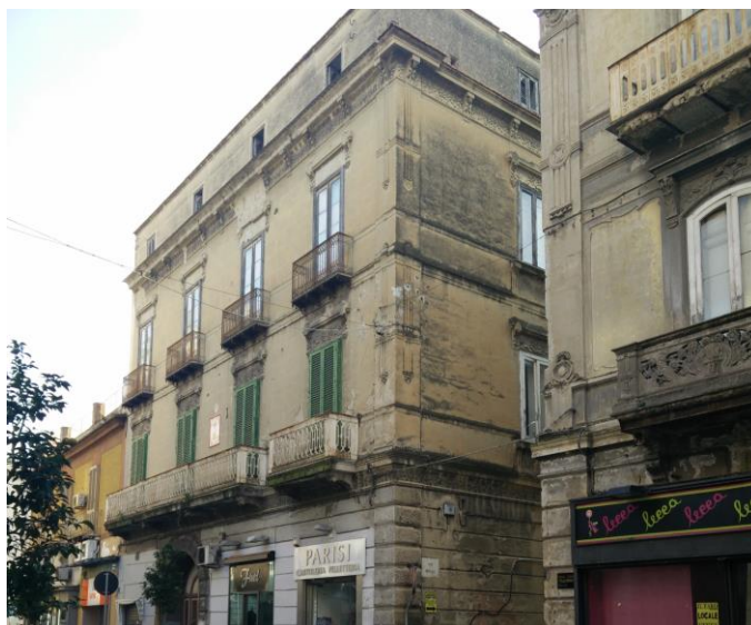
Foto n. 1 – Vista esterna dello stabile
