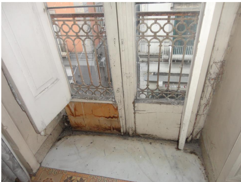
Foto n. 43 – Particolare infisso esterno
