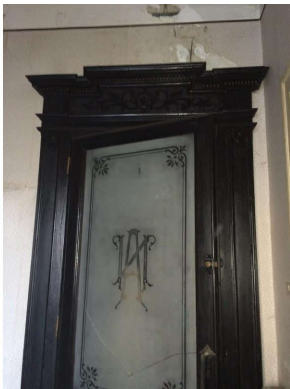
Foto n. 45 – Particolare infisso di accesso all'immobile
