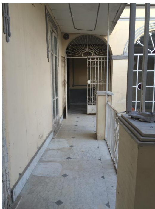
Foto n. 10 – Vista ingresso al ballatoio
