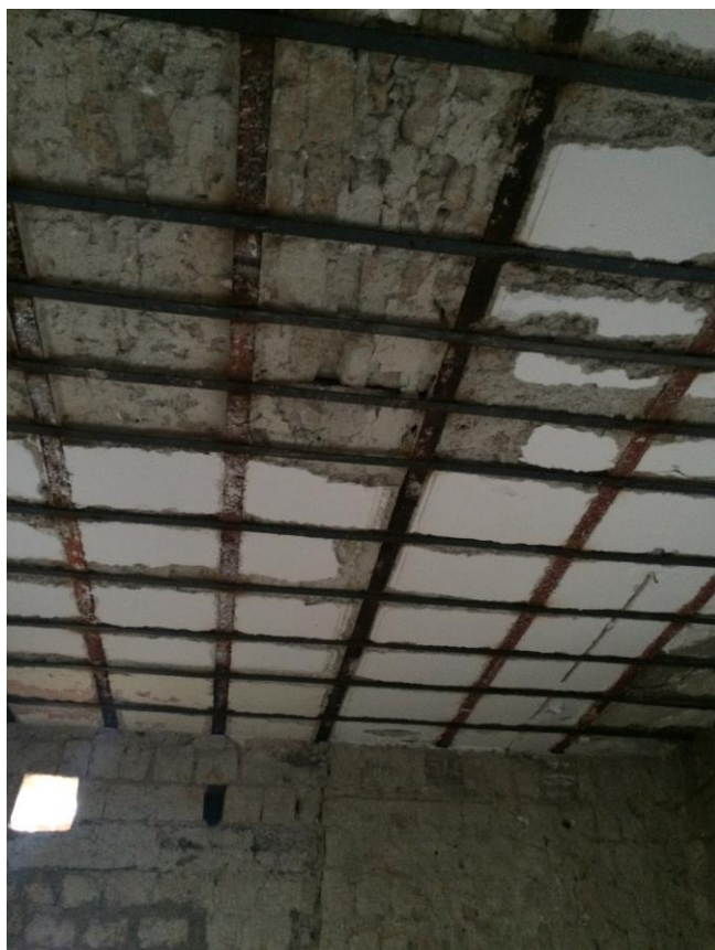
Foto n. 51 – Particolare solaio di copertura interno
