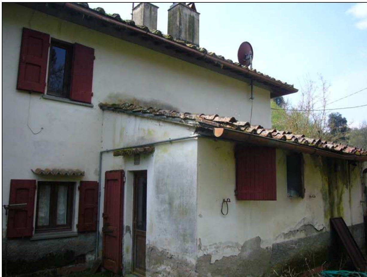
Foto 2– Scorcio del fronte tergale dal resede
