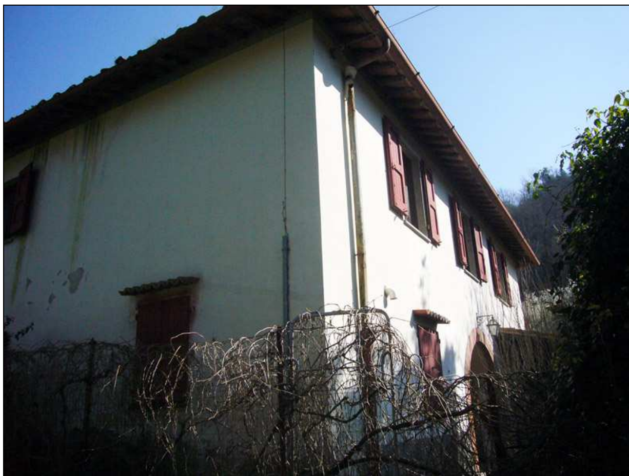
Foto 1 – Scorcio del fronte principale da via Ciro Menotti 133 – Reggello (FI)
