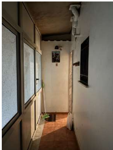
foto n. 9: ballatoio condominiale coperto
