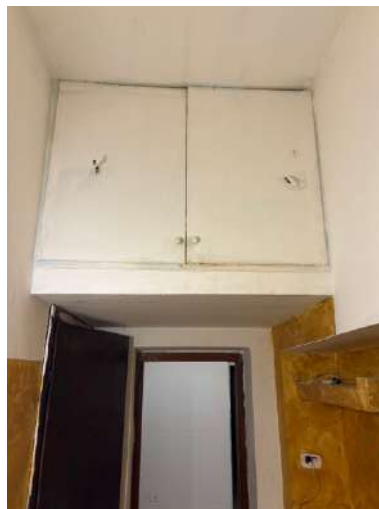
foto n. 20: soppalco non abitabile da demolire
