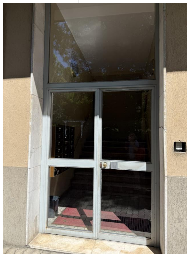
VISTA ACCESSO AL FABBRICATO
