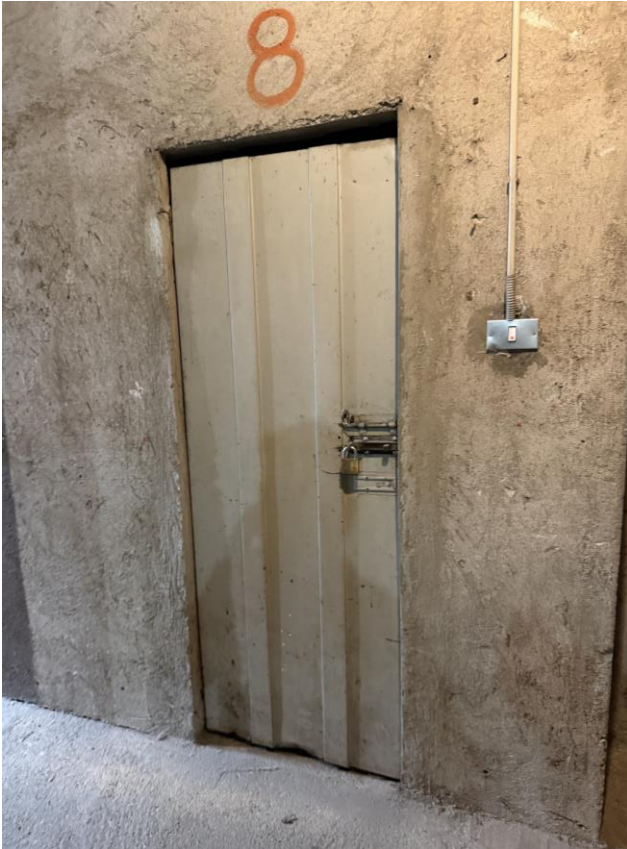
VISTA CANTINA N. 8
