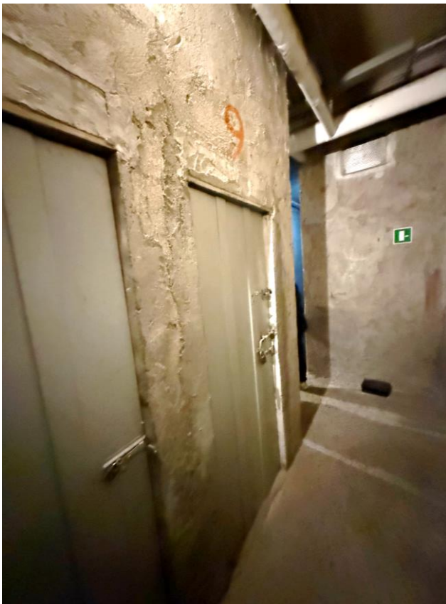
VISTA CANTINA N. 9
