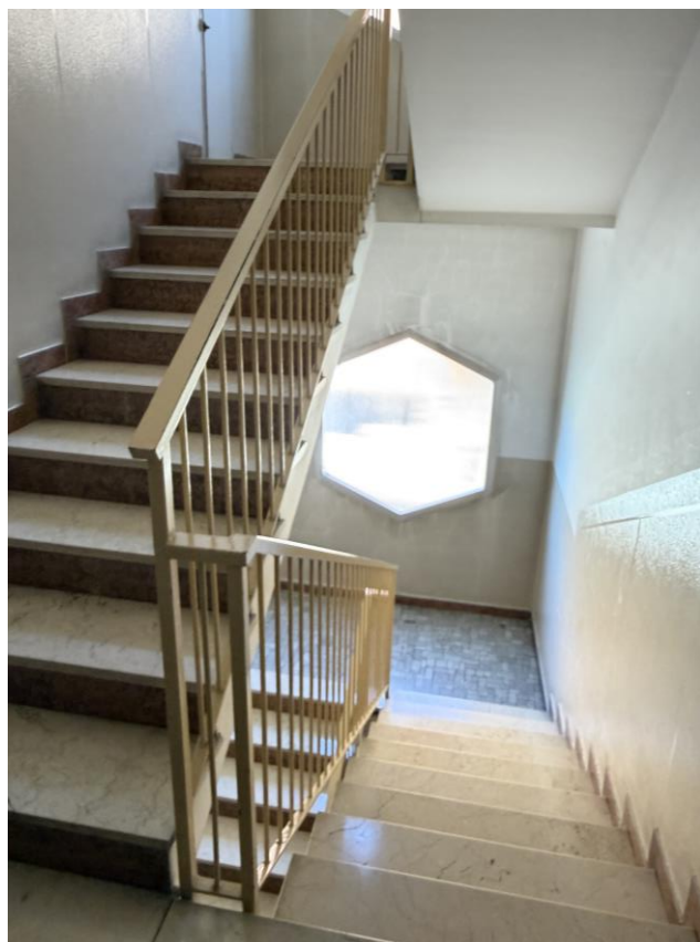
VISTE VANO SCALA E ASCENSORE
