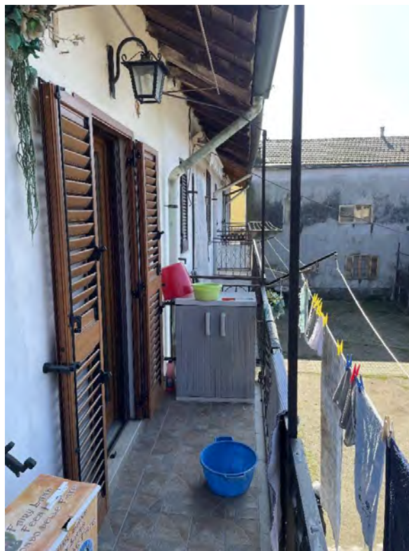
26. Balcone al piano primo.
