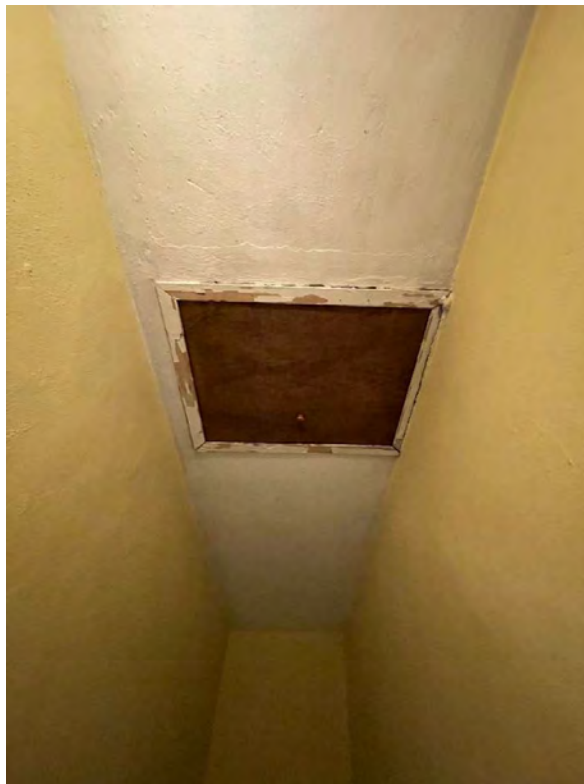
29. Botola di accesso al sottotetto.
