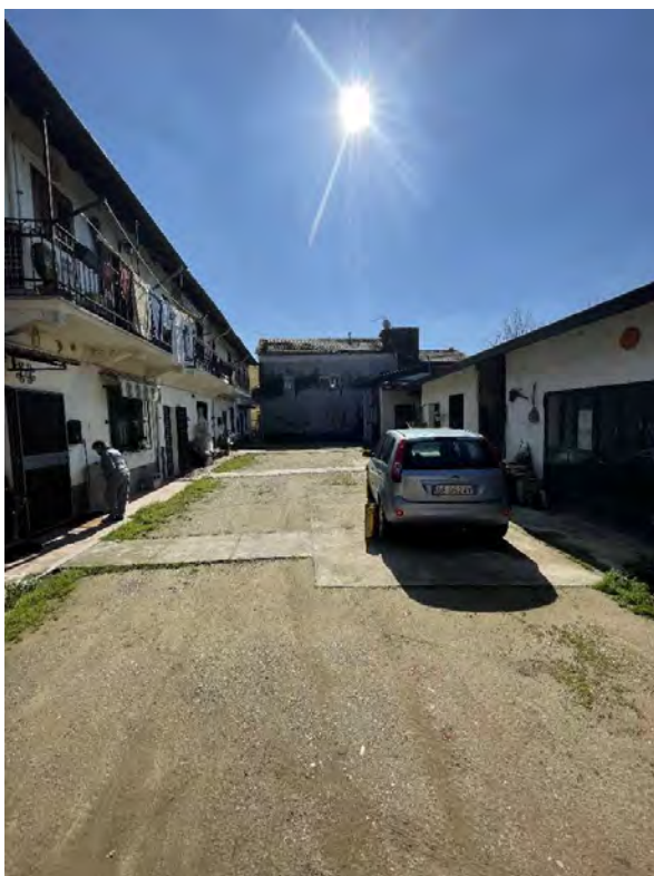
4. Cortile di accesso ai cespiti, vista sud.
