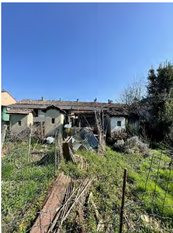
40. Vista lato ovest.
