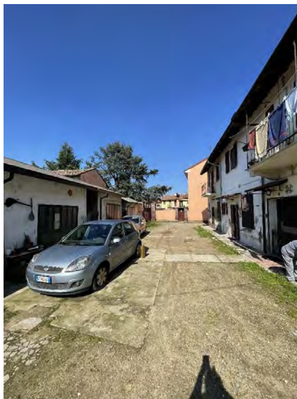
5. Cortile di accesso ai cespiti, vista nord.
