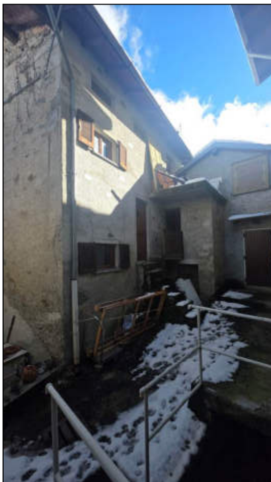
FOTO 5: Fronte sud ovest
