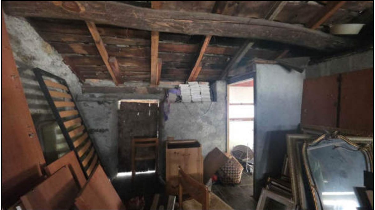
FOTO 11 Vista sottotetto al piano terzo
