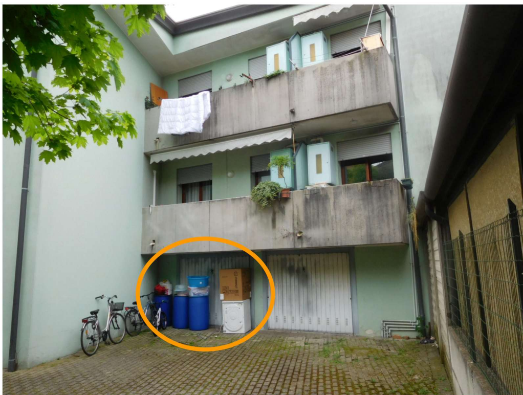
Box auto in area cortilizia condominiale subalterno 10
