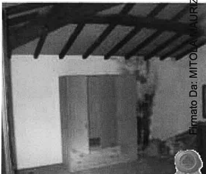
Sottotetto lato ovest privo di pavimentazione, particolare dell'orditura lignea di copertura
