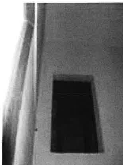
Disimpegno di accesso alla camera tergale ed al sottotetto
