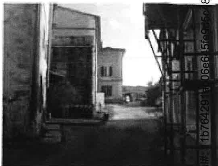
Accesso da ovest alla porzione tergale del borgo Valinardi
