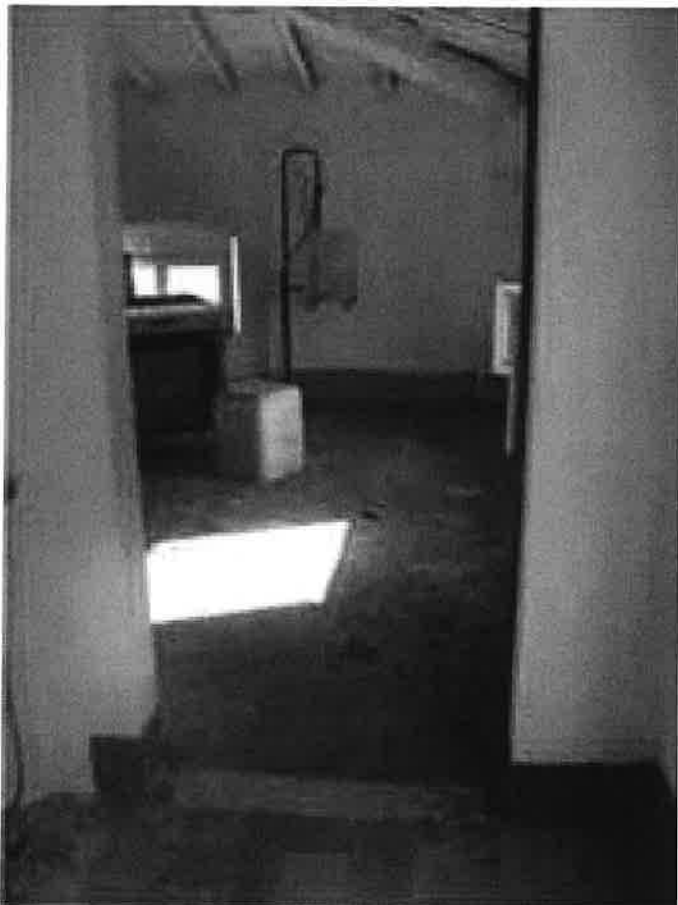
Sottotetto, vano ad Este pavimentato in mezzane posate a spina, particolare dell'orditura lignea di copertura
