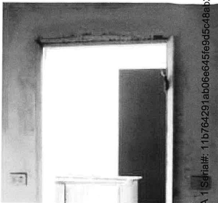
Impianto elettrico sottotraccia
