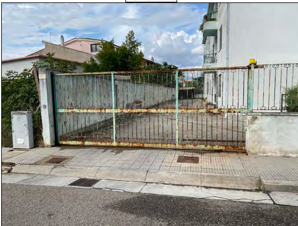
Vista dell'immobile dall'esterno – ingresso edificio passo carrabile lato via Tirso
