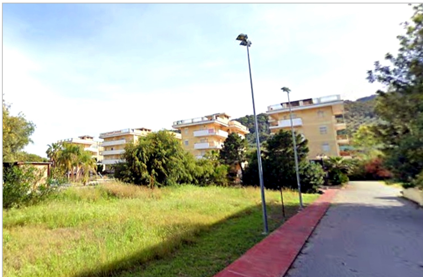
Vista esterna del complesso residenziale
