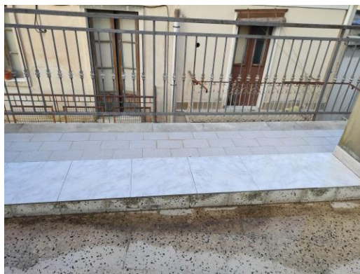
Foto 32, 33,34,35,36,37,38,39,40. Terrazzo di copertura
