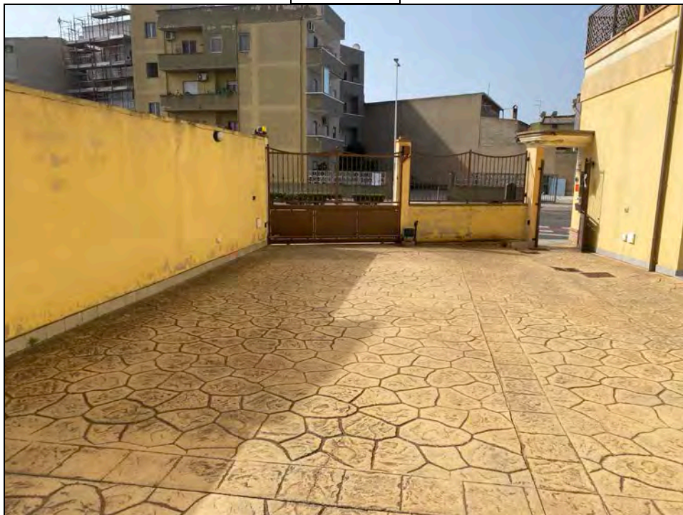
Vista del fabbricato dall'esterno - lato cortile
