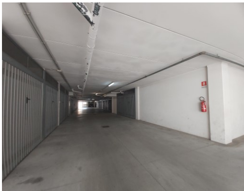
Interrato. Corsia di manovra condominiale.
