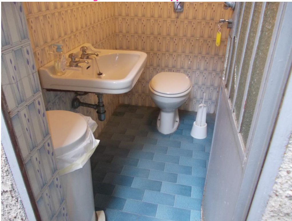
Bagno – sub 709 mappale 159
