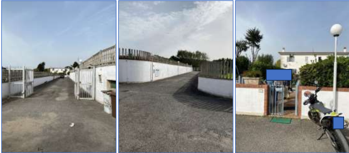
Figura 21. Accesso da via Cuma Licola n. 176 (strada privata).
