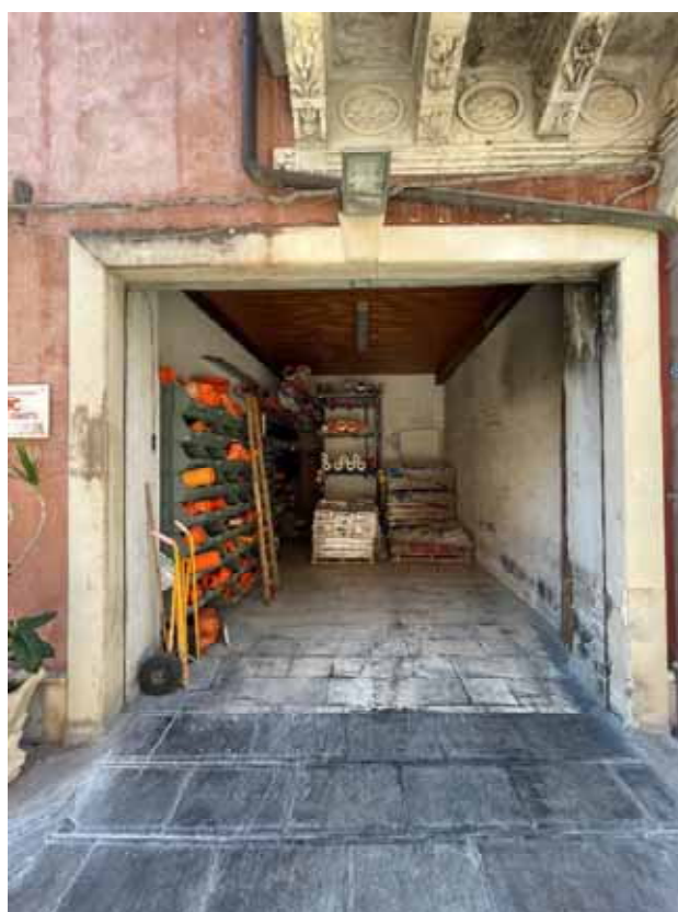
Fig. n.9 -Deposito su via libertà 33
