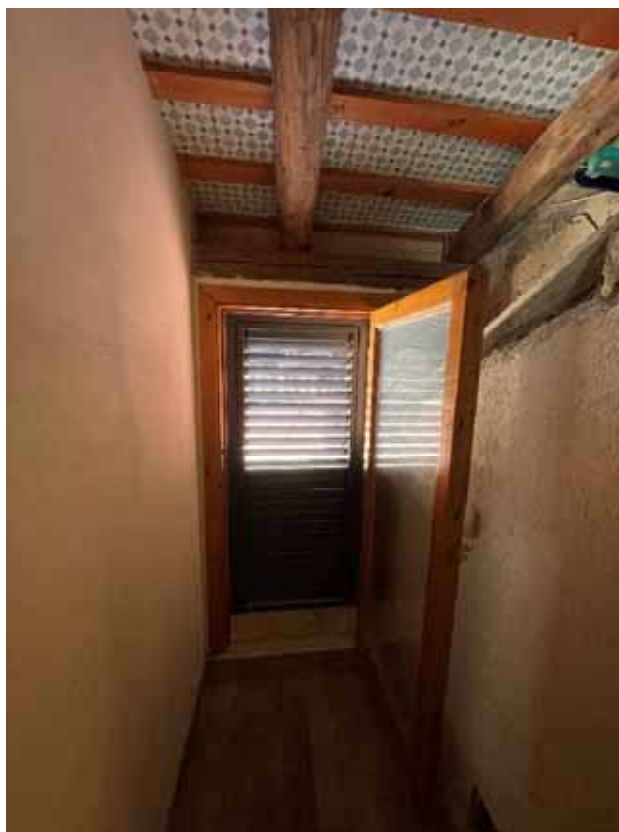
Fig. n.13 – Ripostiglio 2°P modificato pre realizzazione wc
