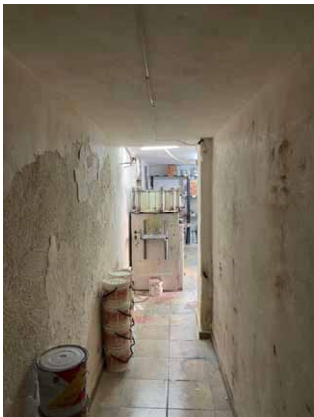
Fig. n.14 - vano piano S1(immobile Pignorato)
