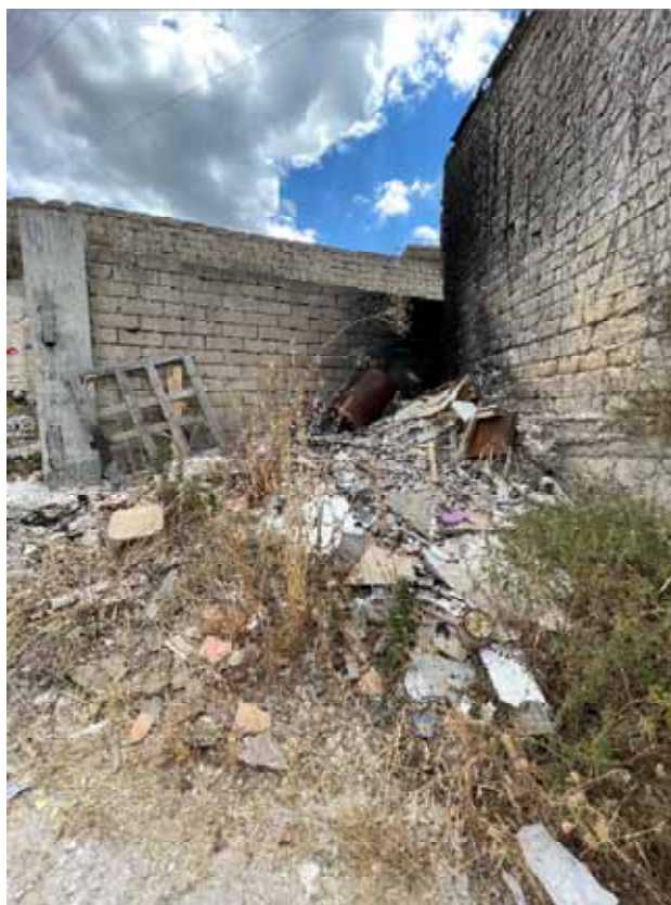
fig. n.4 – lato ovest recinzione e garage
