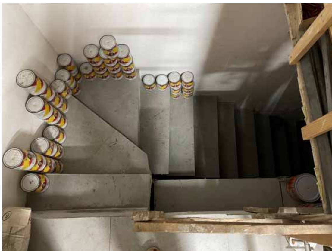
Fig. n.13 – Scala accesso piano S1 (immobile non Pignorato)
