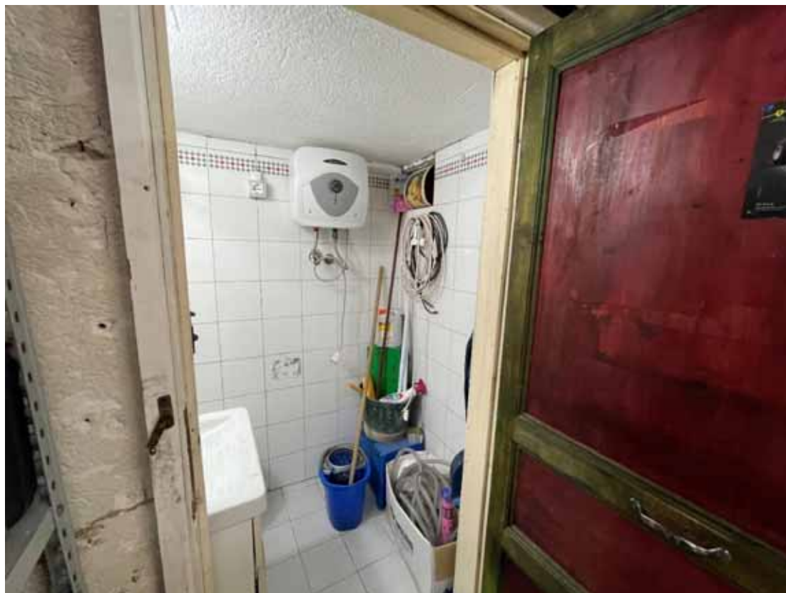
Fig. n.7 - wc LOTTO N°03 - VIA LIBERTÀ 33- SORTINO (SR)
