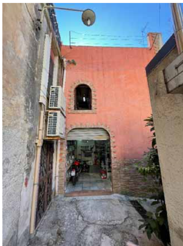
Fig. n.2- Prospetto via Crispi (immobile non pignorato)
