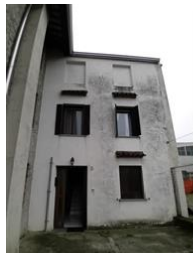
Vista esterna fabbricato ingresso
