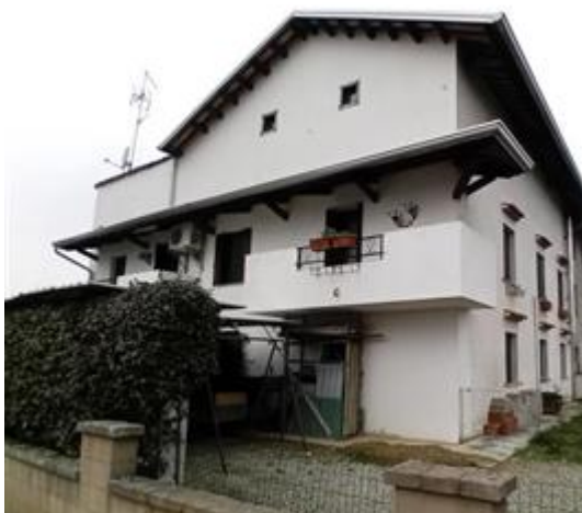
Vista esterna fabbricato
