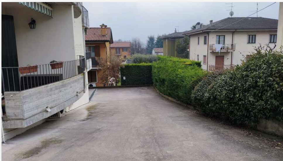
Rampa dello scivolo carraio
