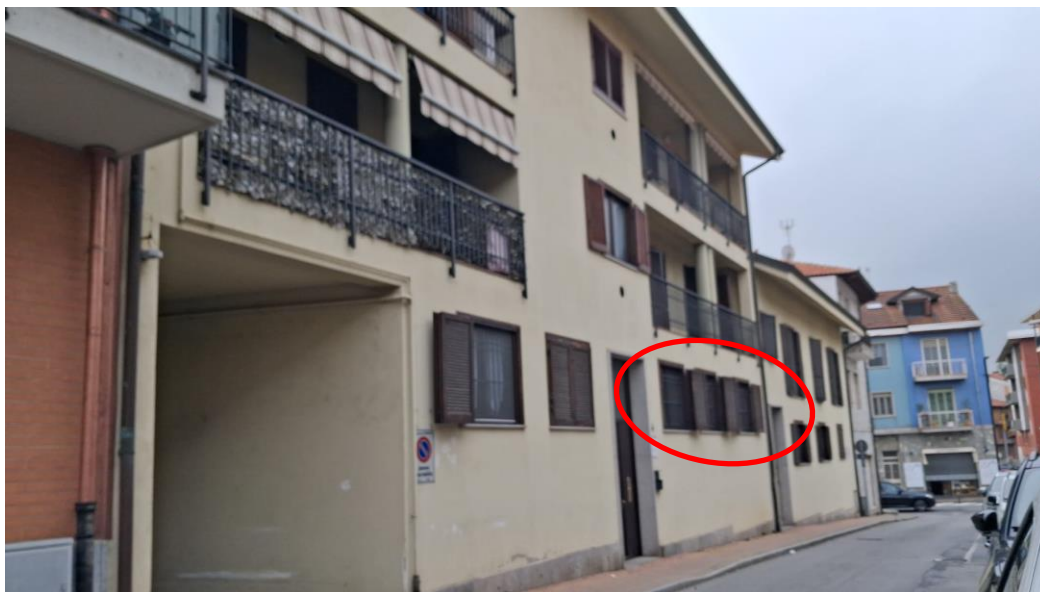
Foto 1 prospetto edificio via Vittorio Veneto
