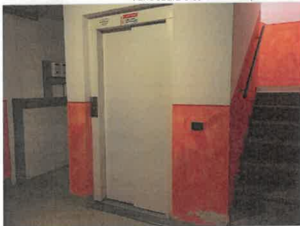
vano scala e ascensore al piano interrato
