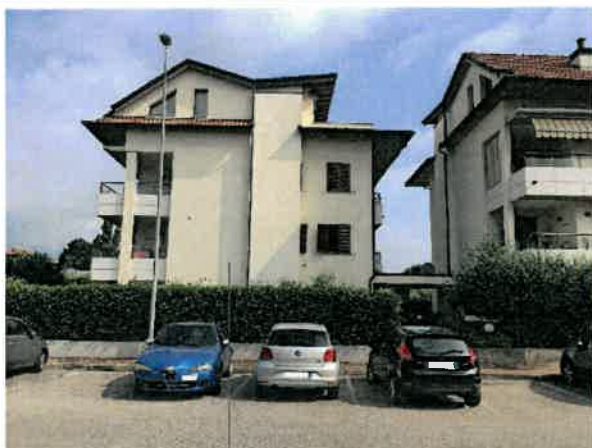
Palazzina C3 del Complesso Europa
