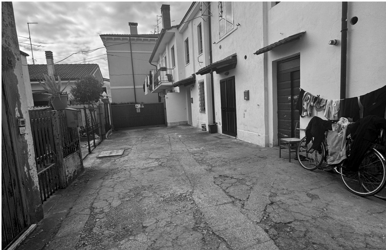
FOTO 6 - Area esterna retro e part. 592
