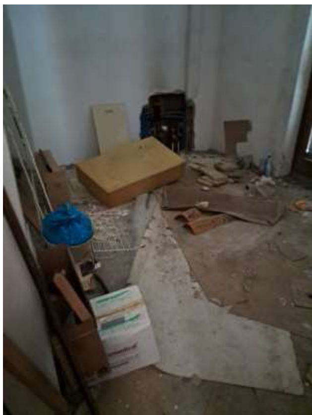
BAGNO PADRONALE IN RISTRUTTURAZIONE
