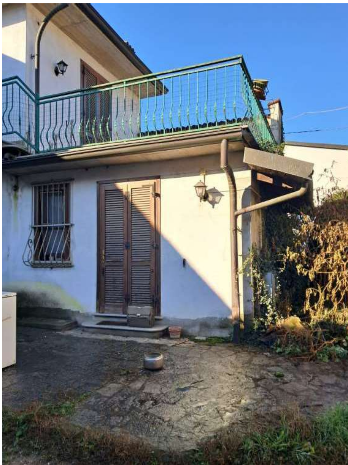
PARTE PROSPETTO NORD – EST (N. 1 PIANO FUORI TERRA + SOPRASTANTE TERRAZZO)
