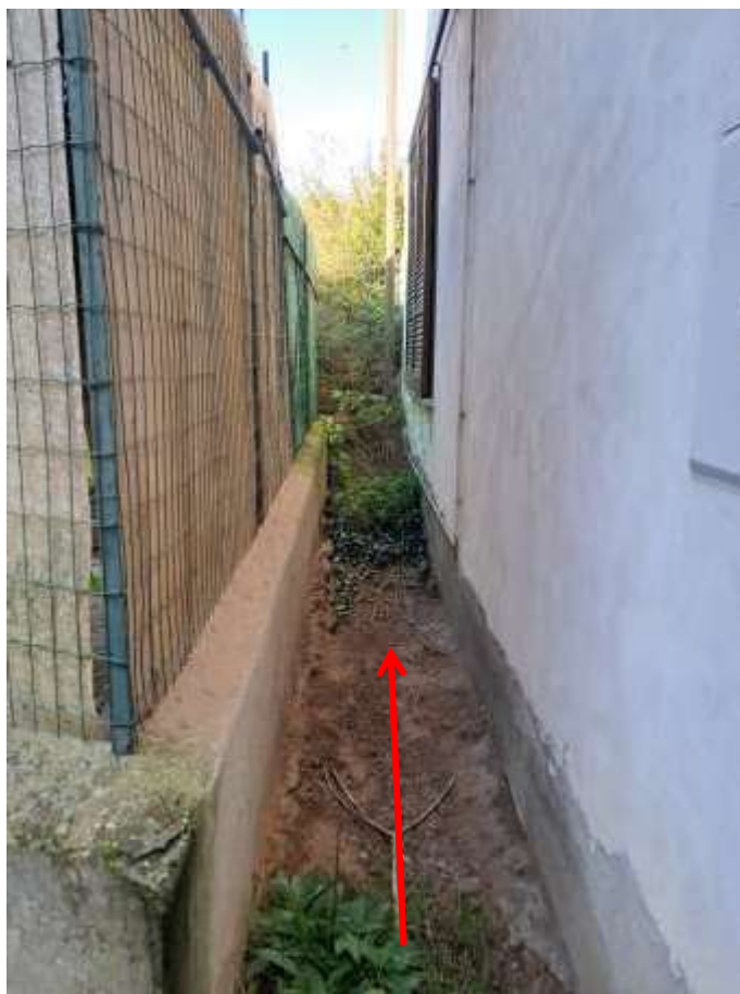
CAVEDIO – PASSAGGIO FRONTE SUD
