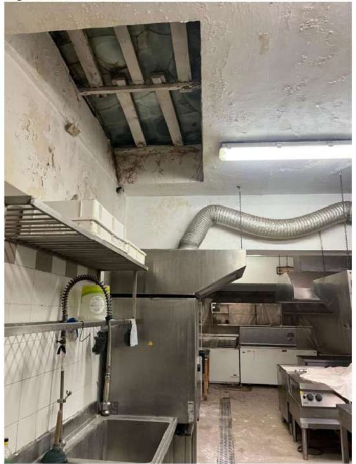
Cucine del ristorante
