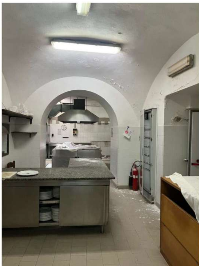
Cucine del ristorante
