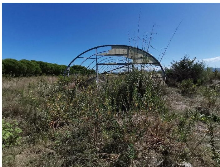
L'area pertinenziale con telai dismessi
