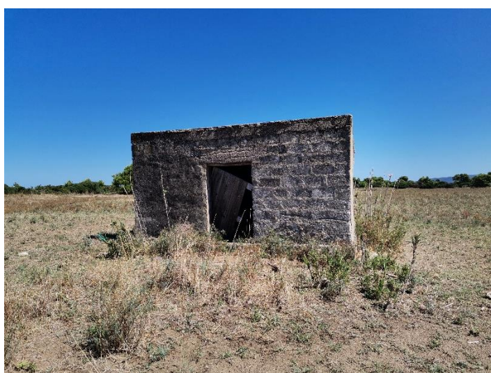
Il fabbricato p.lla 137
