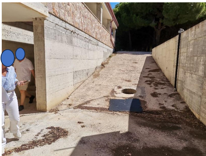
La rampa d'accesso al deposito
