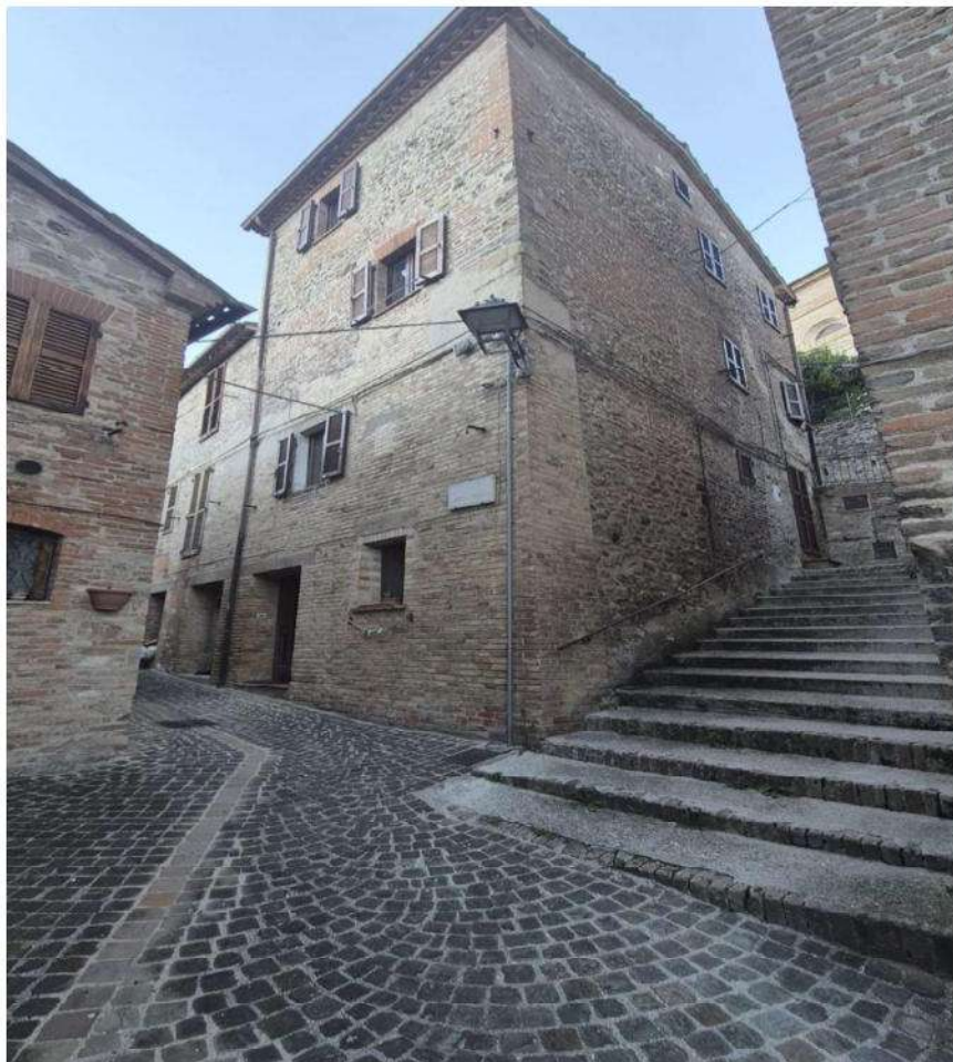
FOTO 1 - Vista prospettica del fabbricato da Via Leopardi
