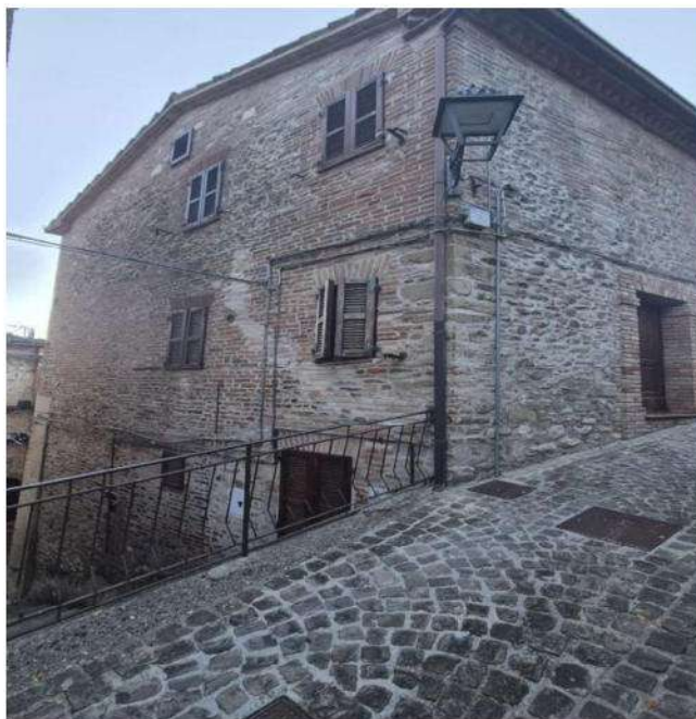
[4] Vista del fabbricato dalla via soprastante
