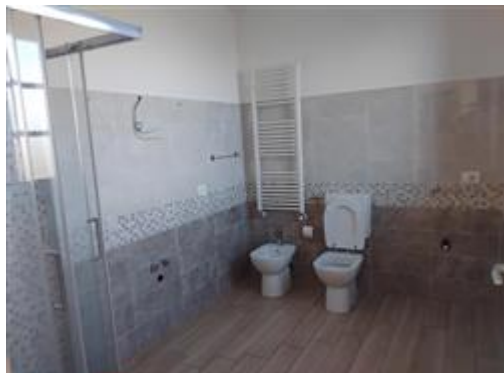
Veduta interno appartamento: servizio igienico al piano 1°
