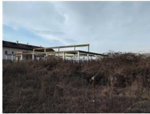
Veduta da sud-est della struttura verticale esistente sull'area (mappale n. 182)
