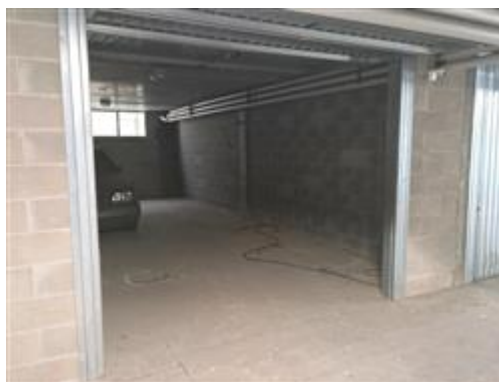
Veduta rimessa al piano interrato (Foglio 9 n. 180 subalterno 54)
