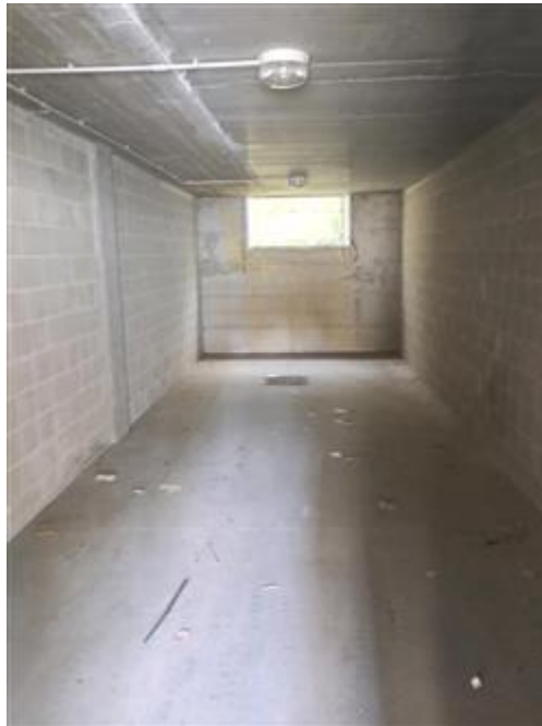
Veduta interno locale di deposito al piano interrato (Foglio 9 n. 180 subalterno 59)
