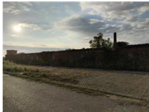
Veduta da nord-ovest dell'area (mappale n. 183)
