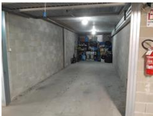
Veduta interno rimessa
