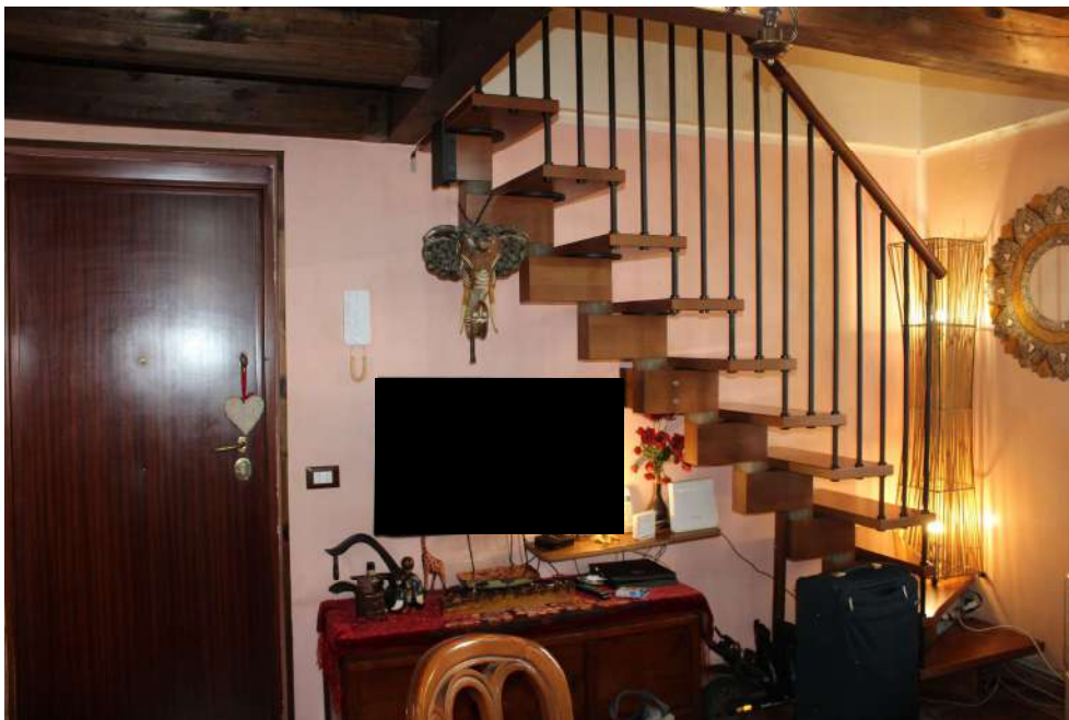
Foto n.16: Scala di accesso al soppalco
