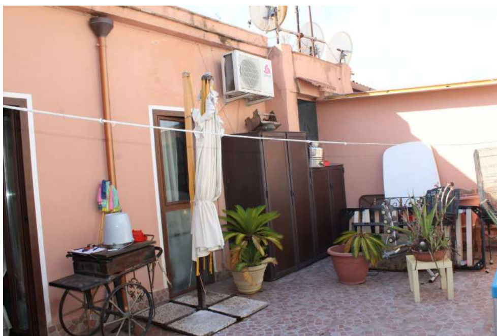
Foto n.9: Terrazza esposta su Via Montalbo
