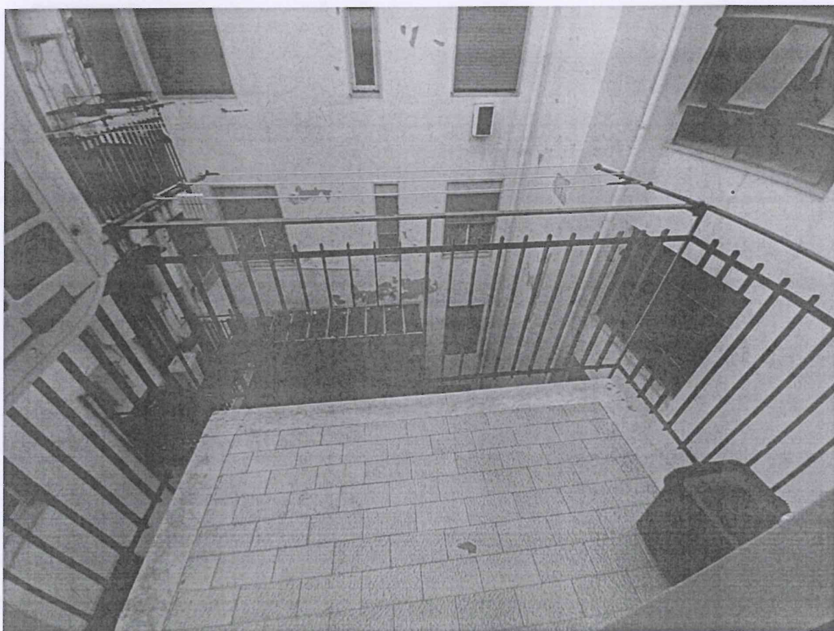
FOTO 18: balcone su cortile interno
