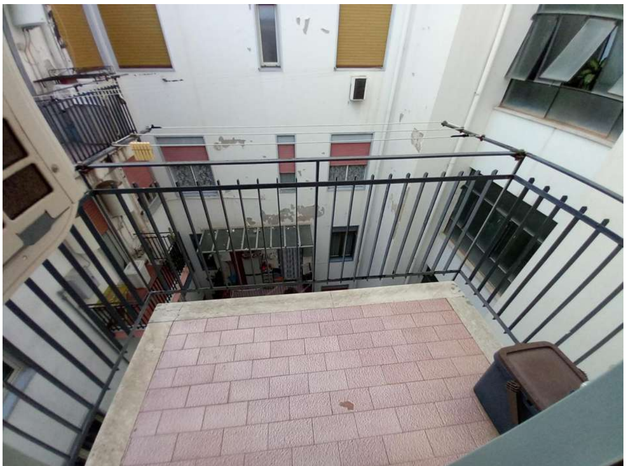
FOTO 18: balcone su cortile interno
