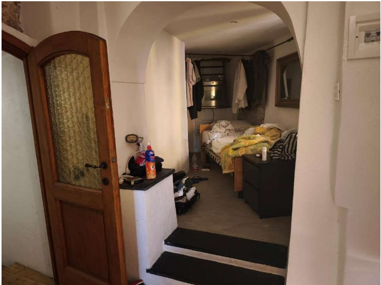
Fotografia 7: varco di comunicazione con altra unità immobiliare da chiudere
