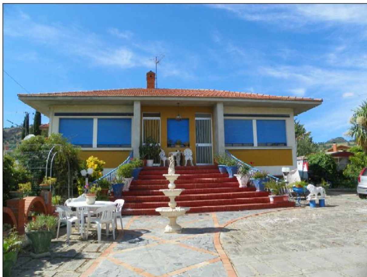
VISTA SUD-EST - Ingresso abitazione ubicata al piano rialzato (LOTTO N°2)
