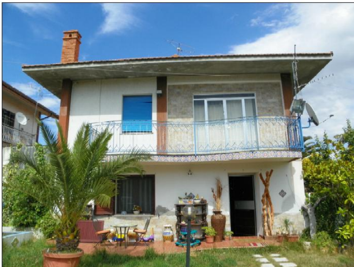
VISTA SUD-OVEST - Ingresso abitazione ubicata al piano seminterrato (LOTTO N°1)
