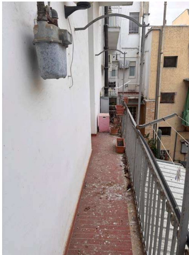
Foto 21: Balcone lato interno (cortile)
