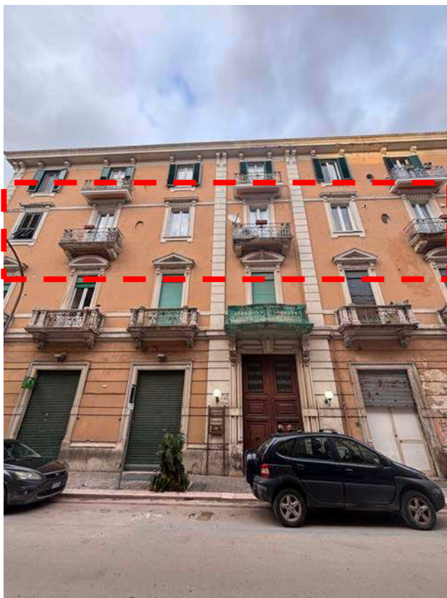
Foto 1: vista ingresso stabile condominiale via Monfalcone n. 38
