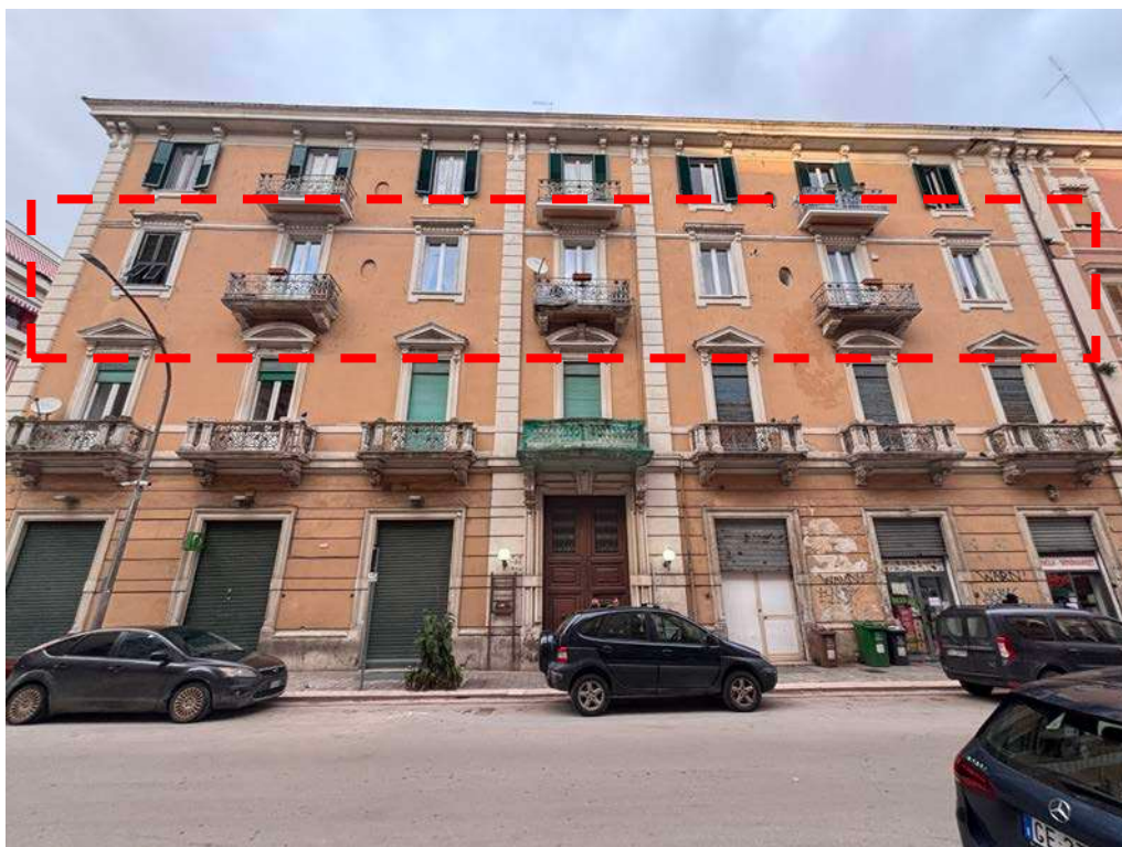
Foto 2: vista completa stabile condominiale
