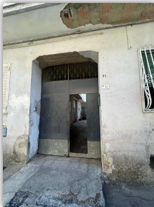
Cancello di accesso al fabbricato
