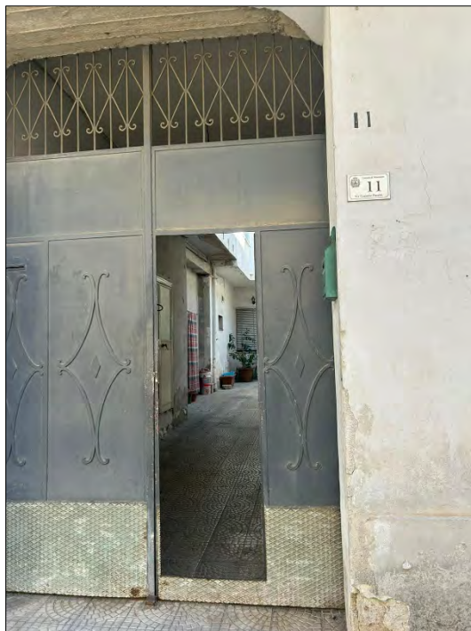
Cancello di ingresso all'immobile
