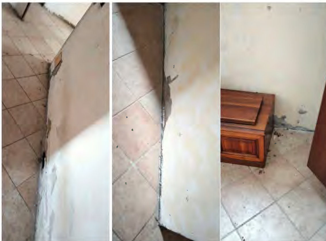
Foto 48 – C.F. Part. 181 / PT particolari umidità di risalita su murature esterne e interne
