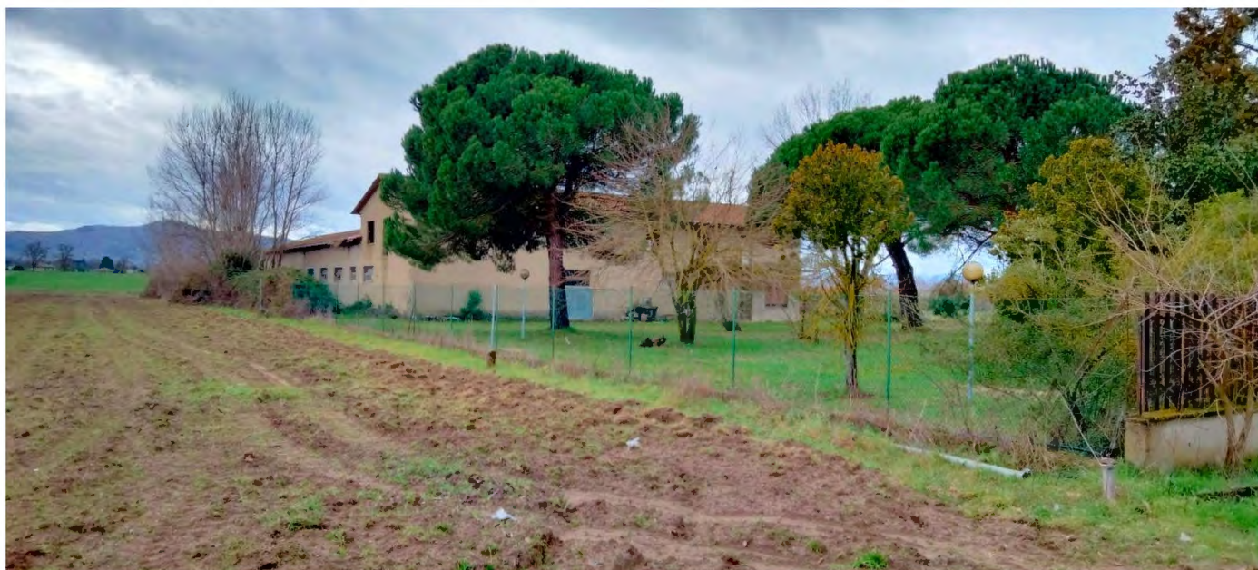
Foto 3 - C.T. Part. 181 (entro la recinzione) / C.F. Part. 181
