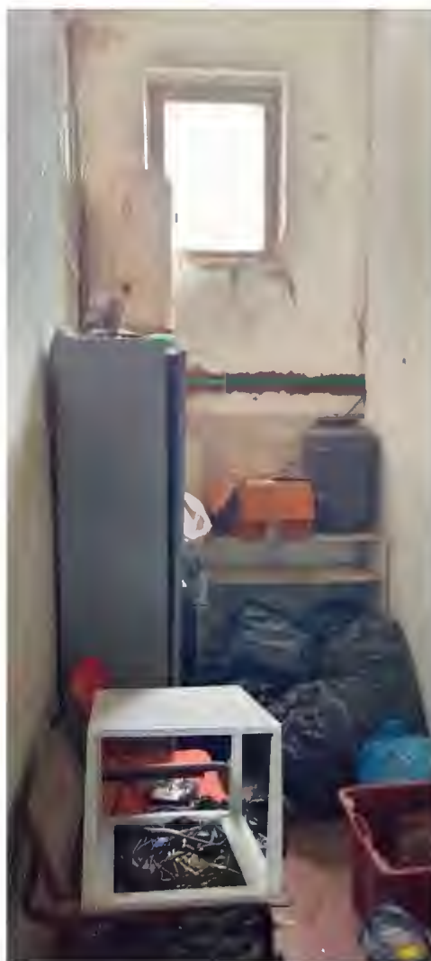
Foto 38 – C.F. Part. 181 / PT locale disimpegno
