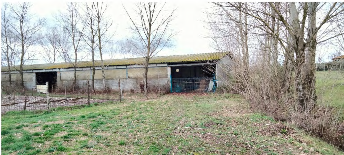
Foto 23 – C.F. Part. 257 / Ingresso
