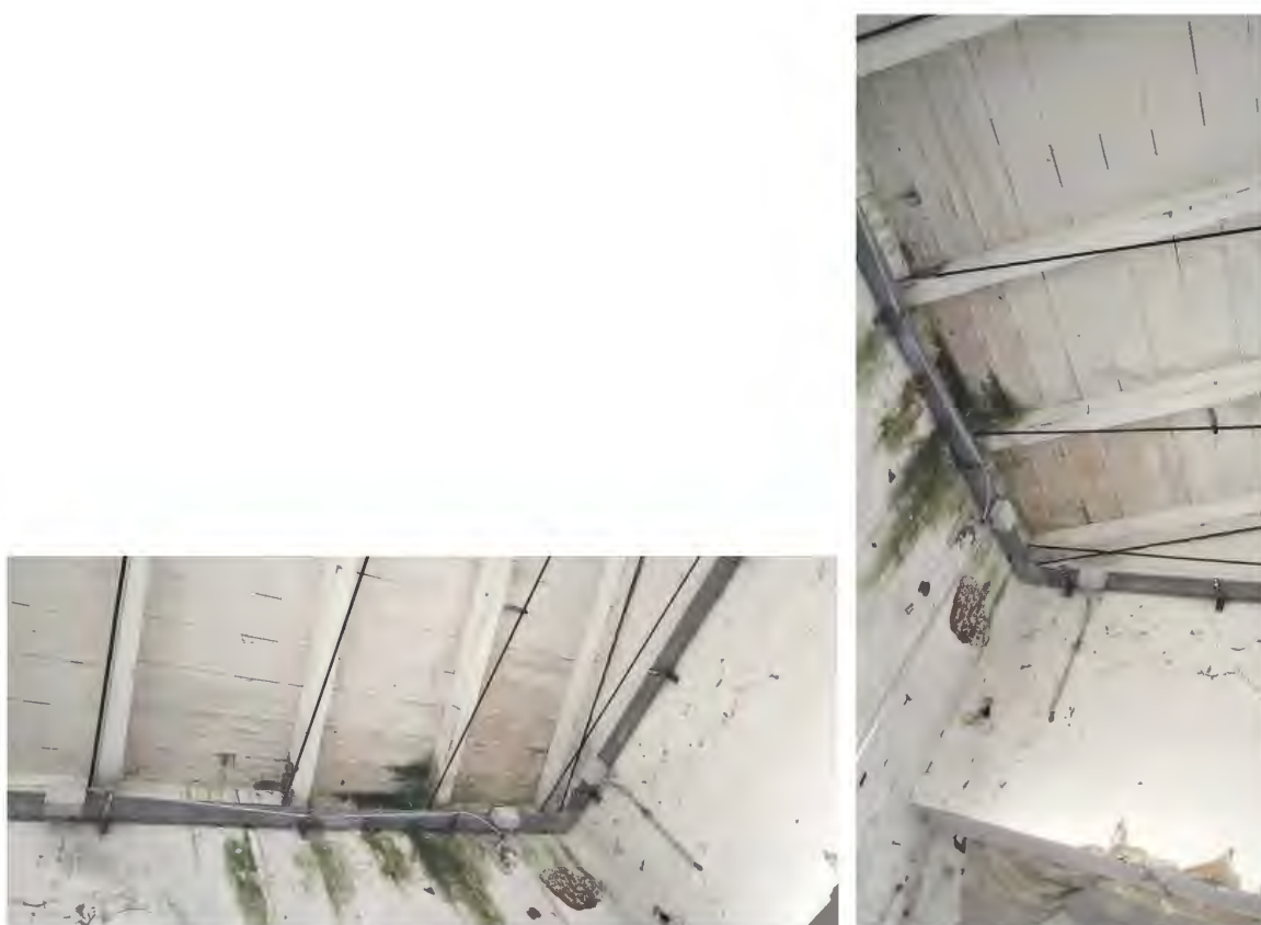
Foto 50 – C.F. Part. 181 / PT deposito macchine particolare accesso acque meteoriche
