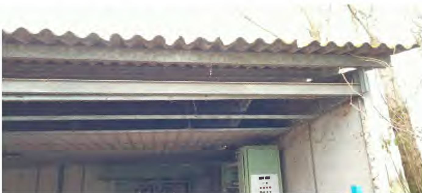
Foto 26 – C.F. Part. 257 / particolare copertura e controsoffitto Eternit
