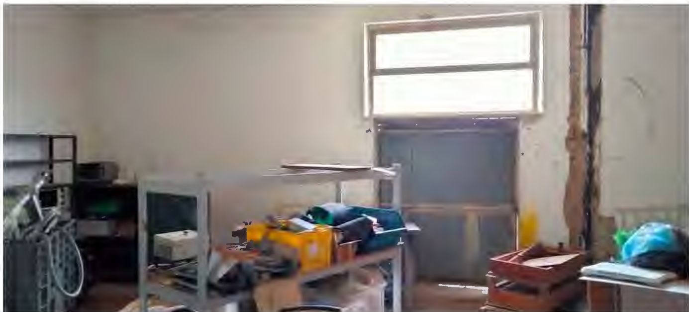
Foto 37 – C.F. Part. 181 / PT locale magazzino 1/officina adiacente deposito macchine
