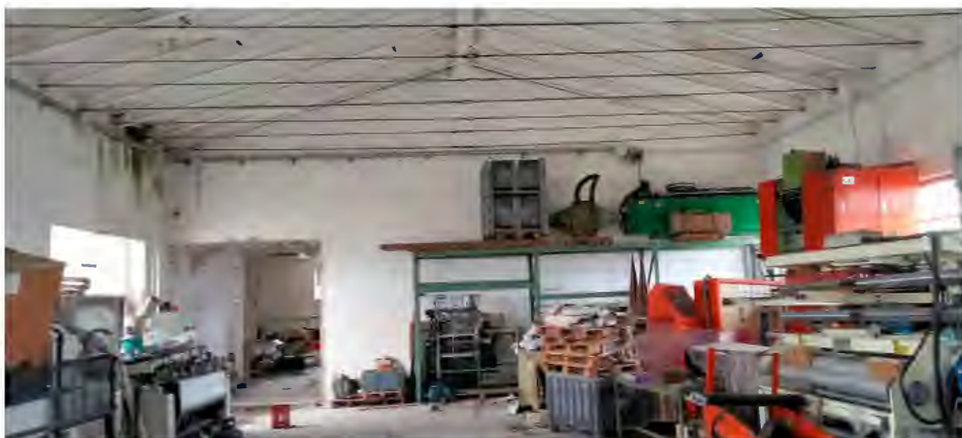
Foto 34 – C.F. Part. 181 / PT deposito macchine
