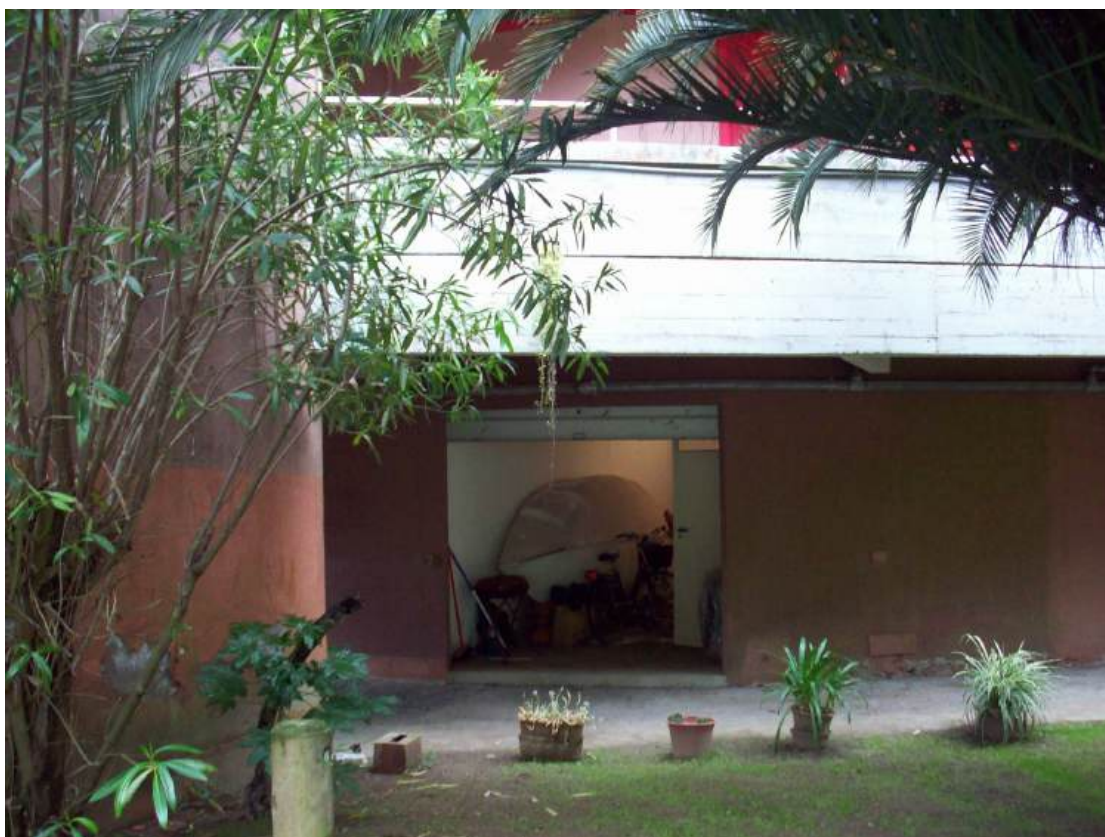
Foto n. 19 - Vista ingresso locale a piano terra accatastato come cantina
