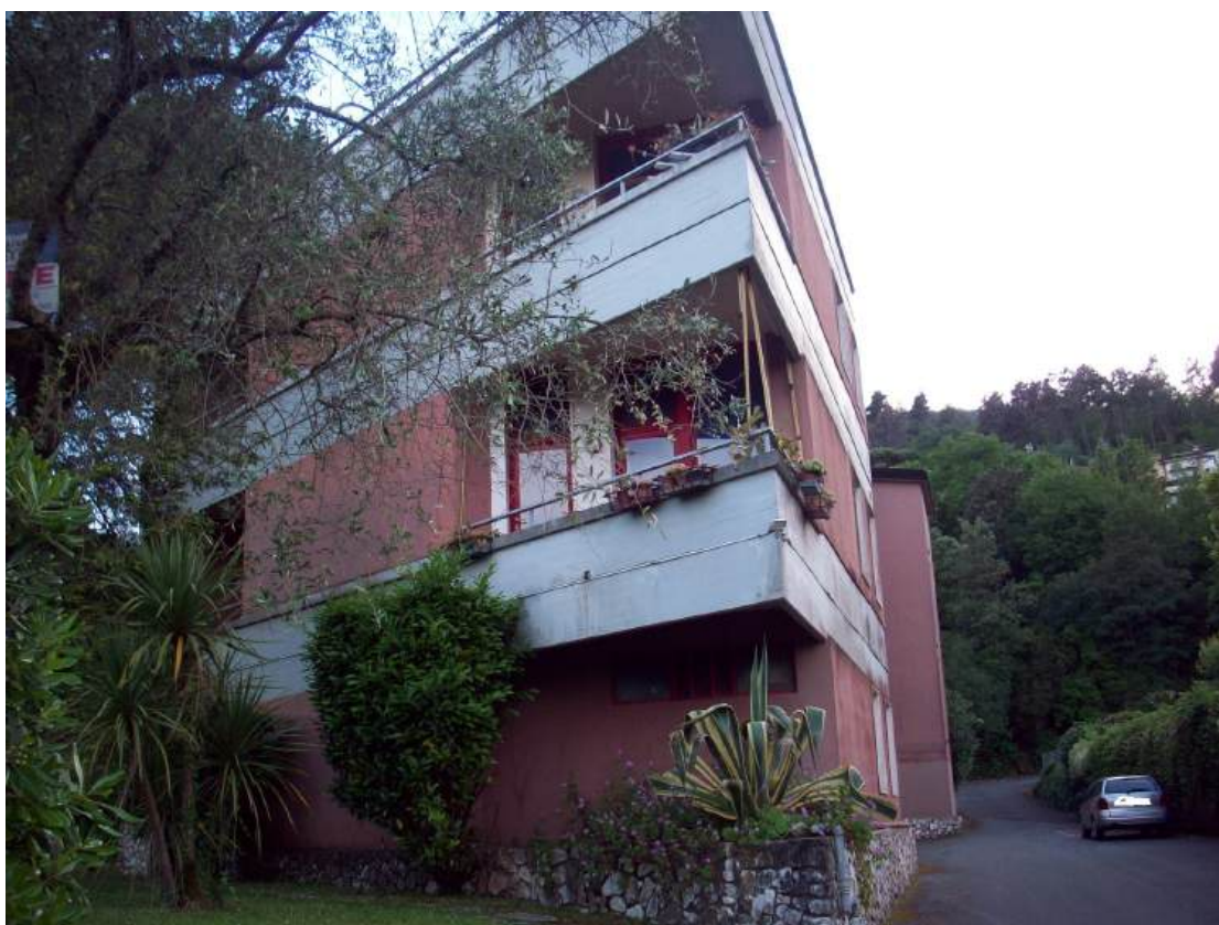
Foto n. 4 - Vista da Via della Pace su strada interna di accesso
