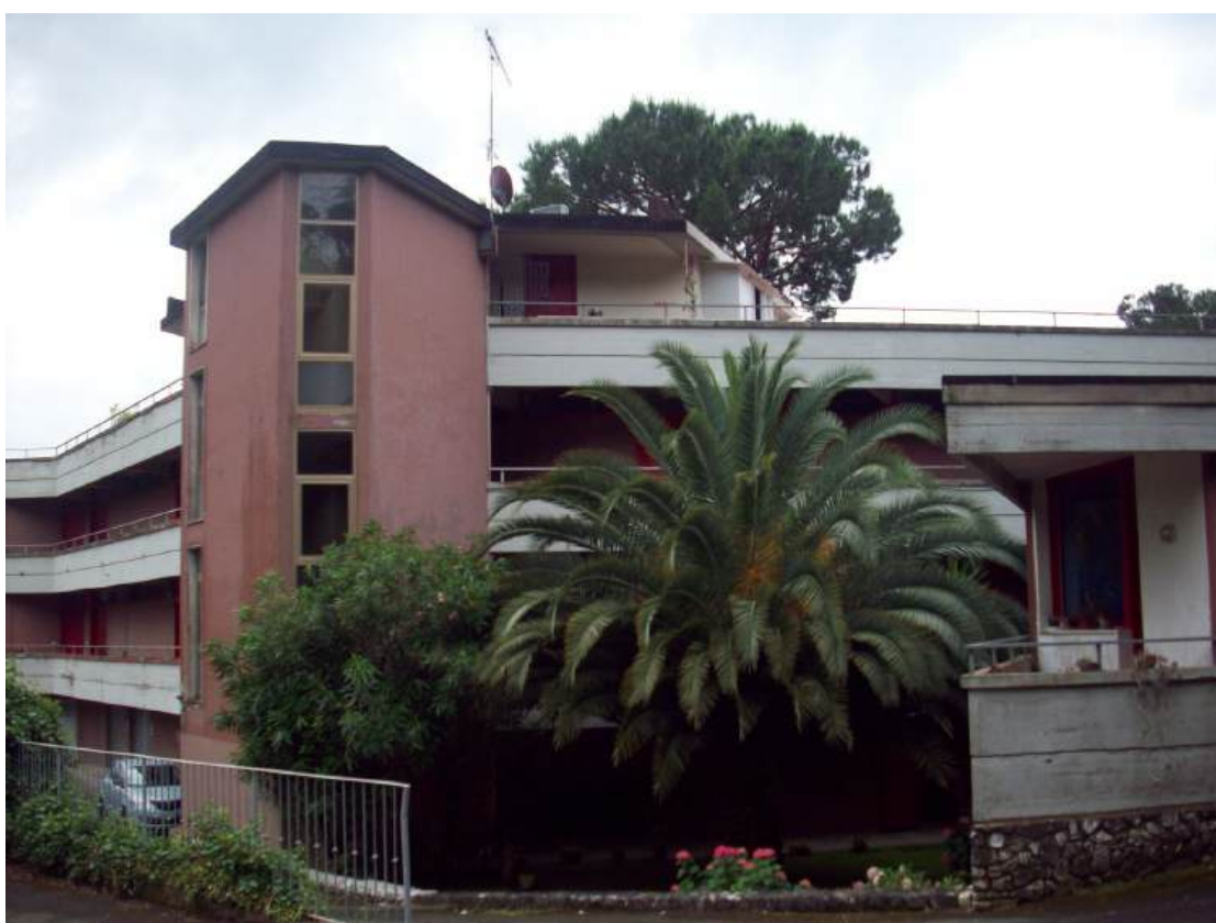
Foto n. 6 - Vista fabbricato da area esterna condominiale
