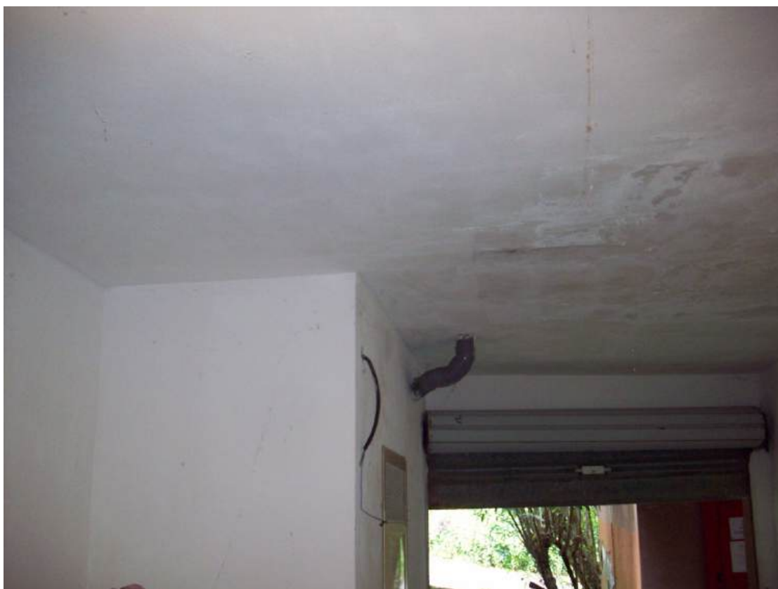
Foto n. 22 - interno locale al piano terra
