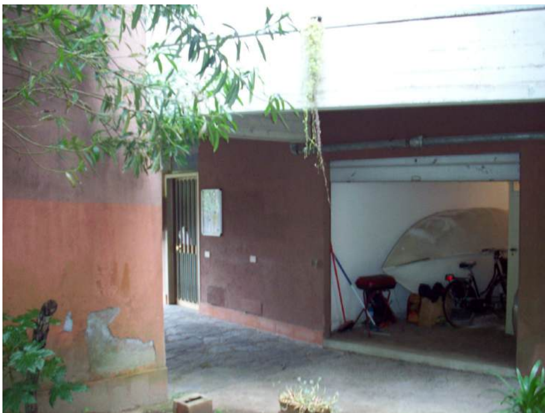
Foto n. 20 - Vista ingresso locale a piano terra accatastato come cantina
