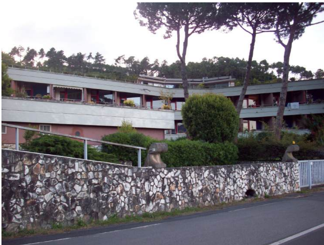
Foto n. 2 - Vista fabbricato da Via della Pace
