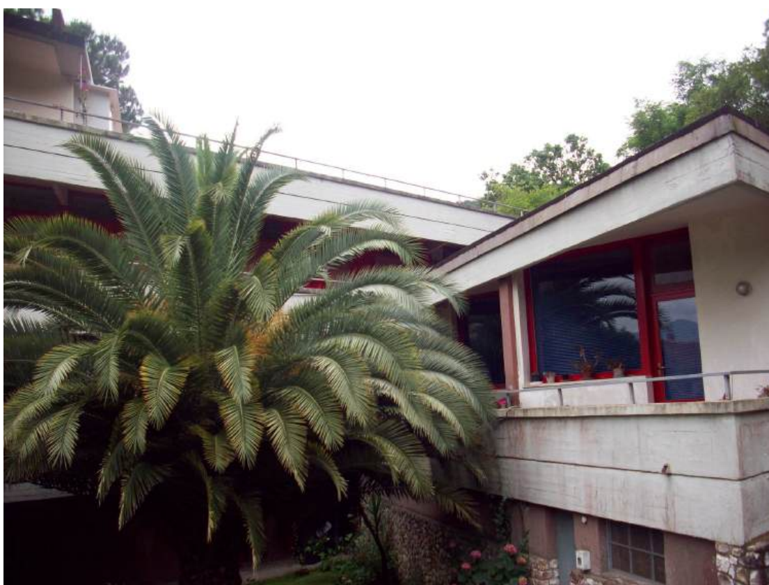
Foto n. 8 - Vista fabbricato da area esterna condominiale
