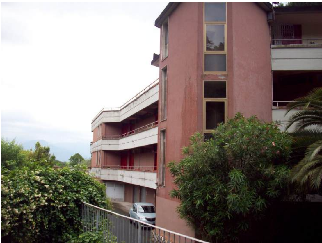
Foto n. 5 - Vista fabbricato da area esterna condominiale
