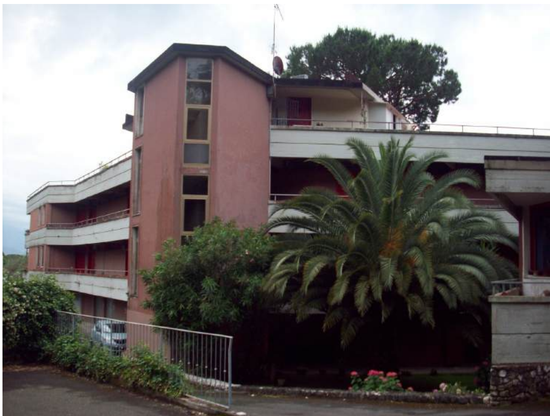
Foto n. 7 - Vista fabbricato da area esterna condominiale
