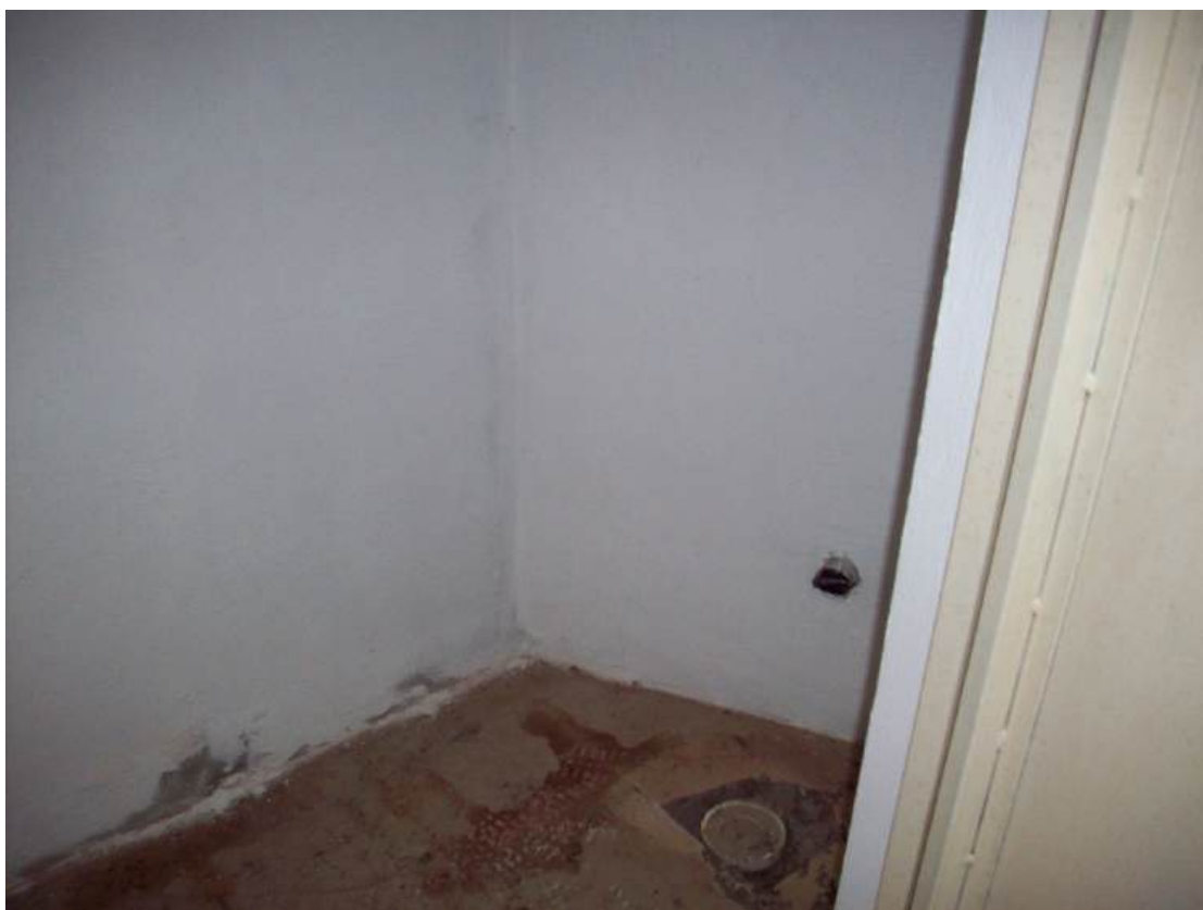
Foto n. 25 - interno locale al piano terra
