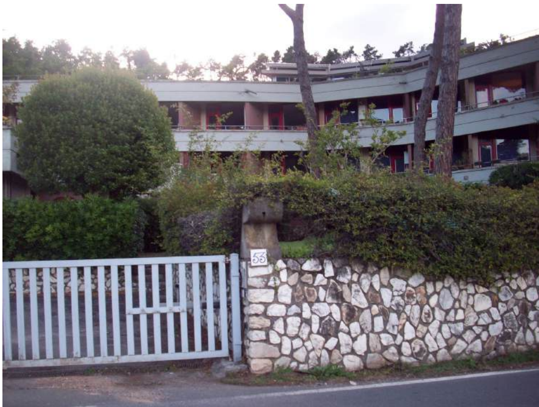
Foto n. 3 - Vista fabbricato da Via della Pace
