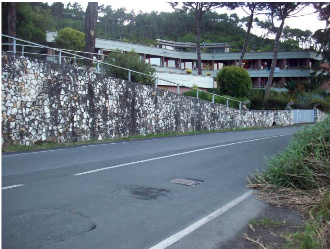
Foto n. 1 - Vista fabbricato da Via della Pace
