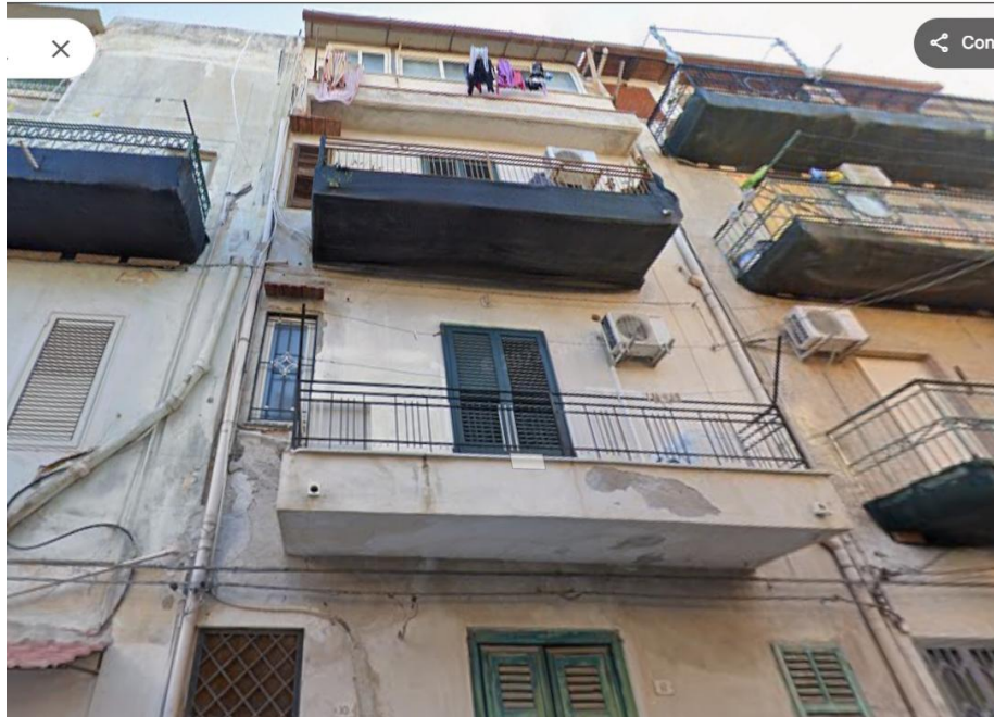
Foto 2: facciata della palazzina
