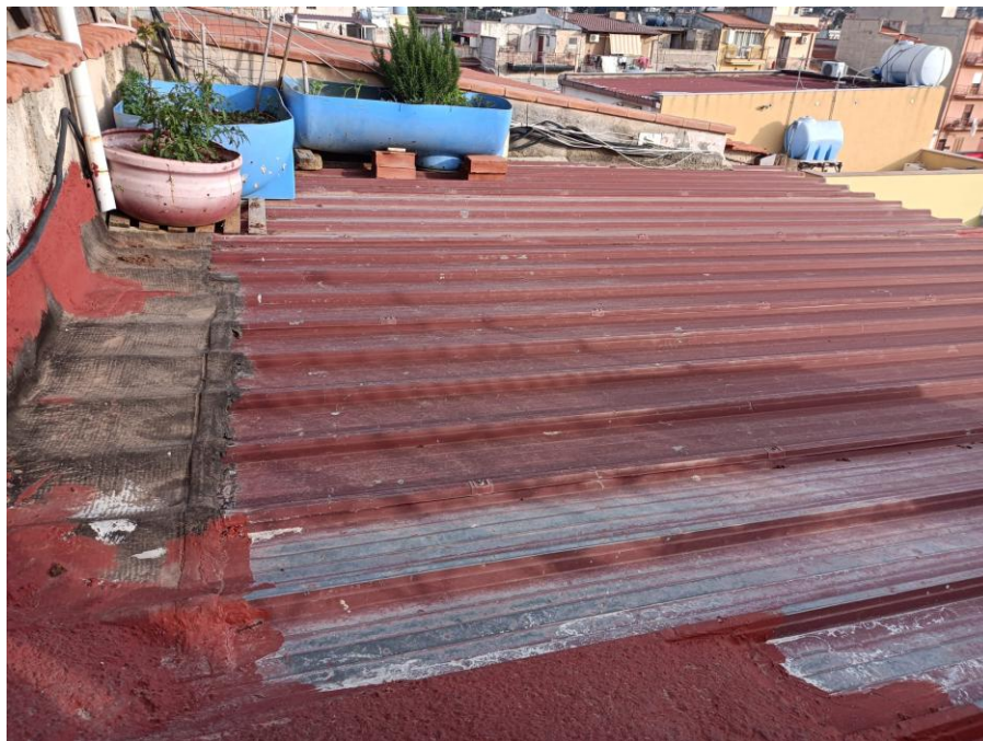
Foto 20: lamiera grecata su copertura lignea
