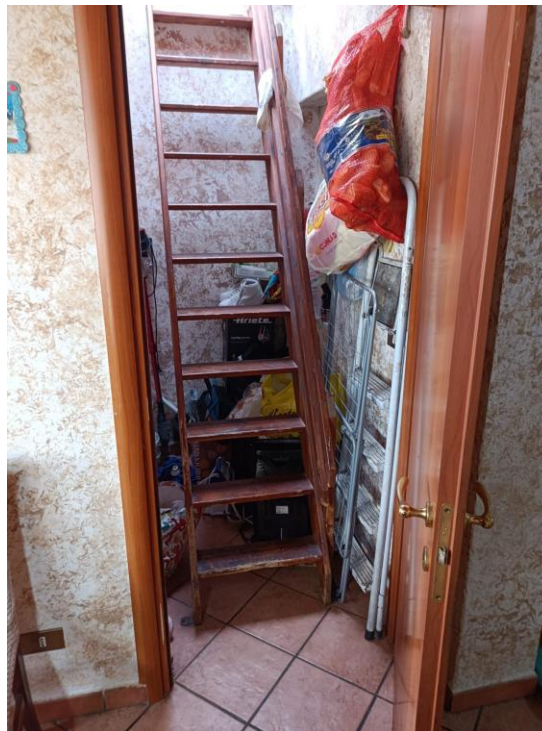
Foto 19: vano con scala verso la copertura lignea
