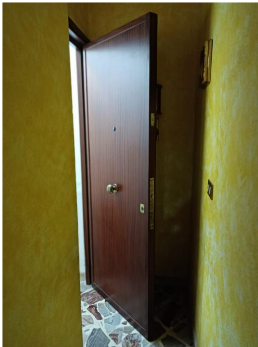
Foto 6: porta blindata di ingresso all'appartamento sulla cameretta al secondo piano
