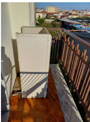
Balcone lato Sud
