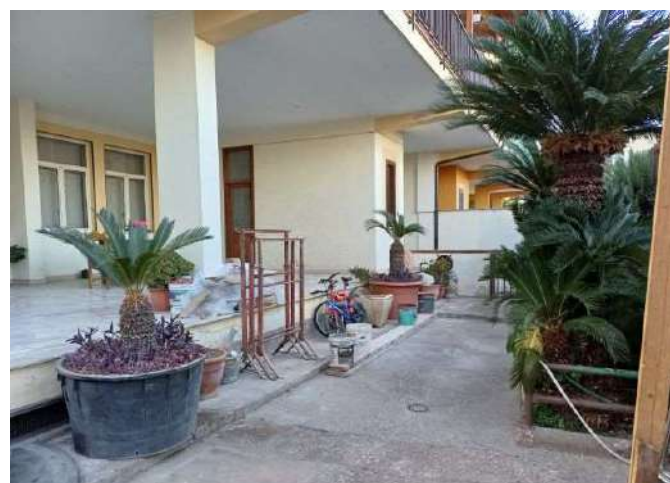
Cortile e porticato antistante l'abitazione
