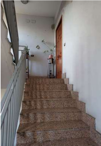
Vano scala – Ingresso appartamento piano secondo –
