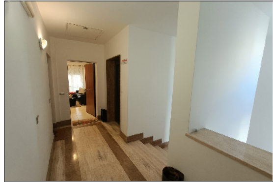
Foto 10 – Vano scala e ascensore P2°
