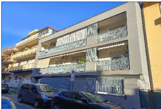
Foto 2 - Vista del prospetto su via F. Orlando
