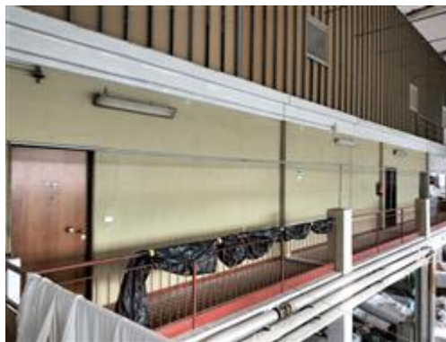
Ingresso all'appartamento dal soppalco del piano primo
