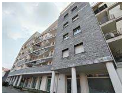
Particolare esterno: dettaglio edificio da via Jefferson
