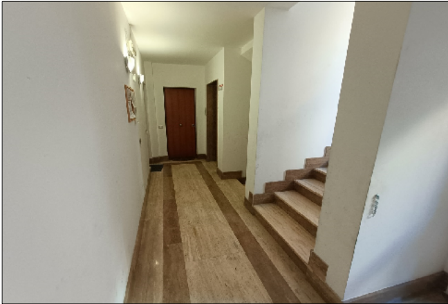
Foto 8- Vano scala e ascensore PT
