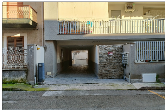
Foto 3 – Accesso al fabbricato civ. 5
