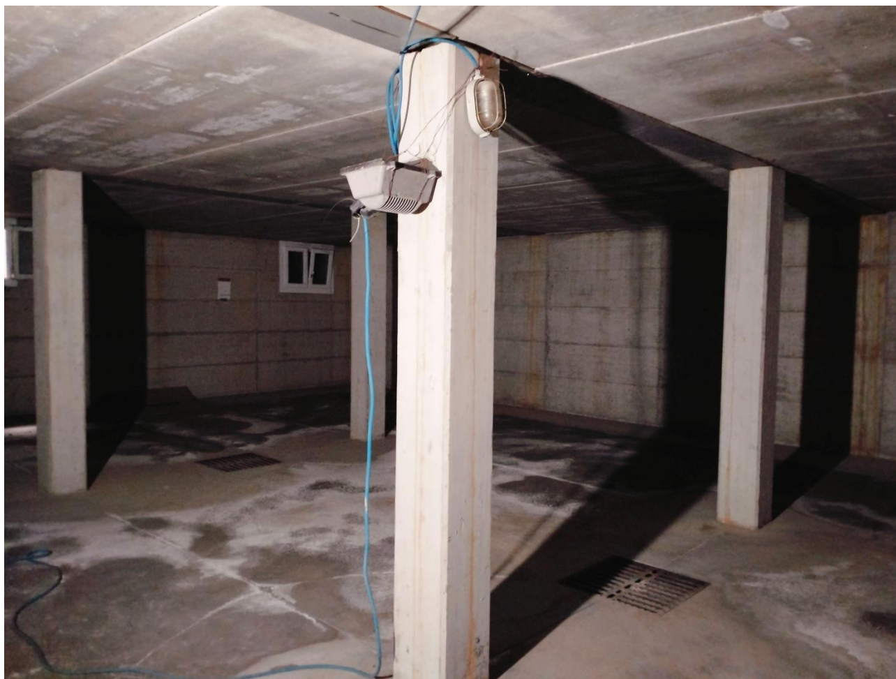
FOTO 27 – P.S: Deposito di pertinenza
