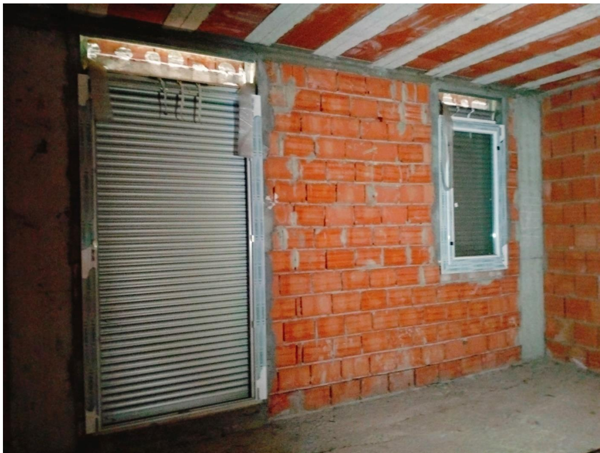
FOTO 18 – P.2º: Camera 3 con cabina armadio
