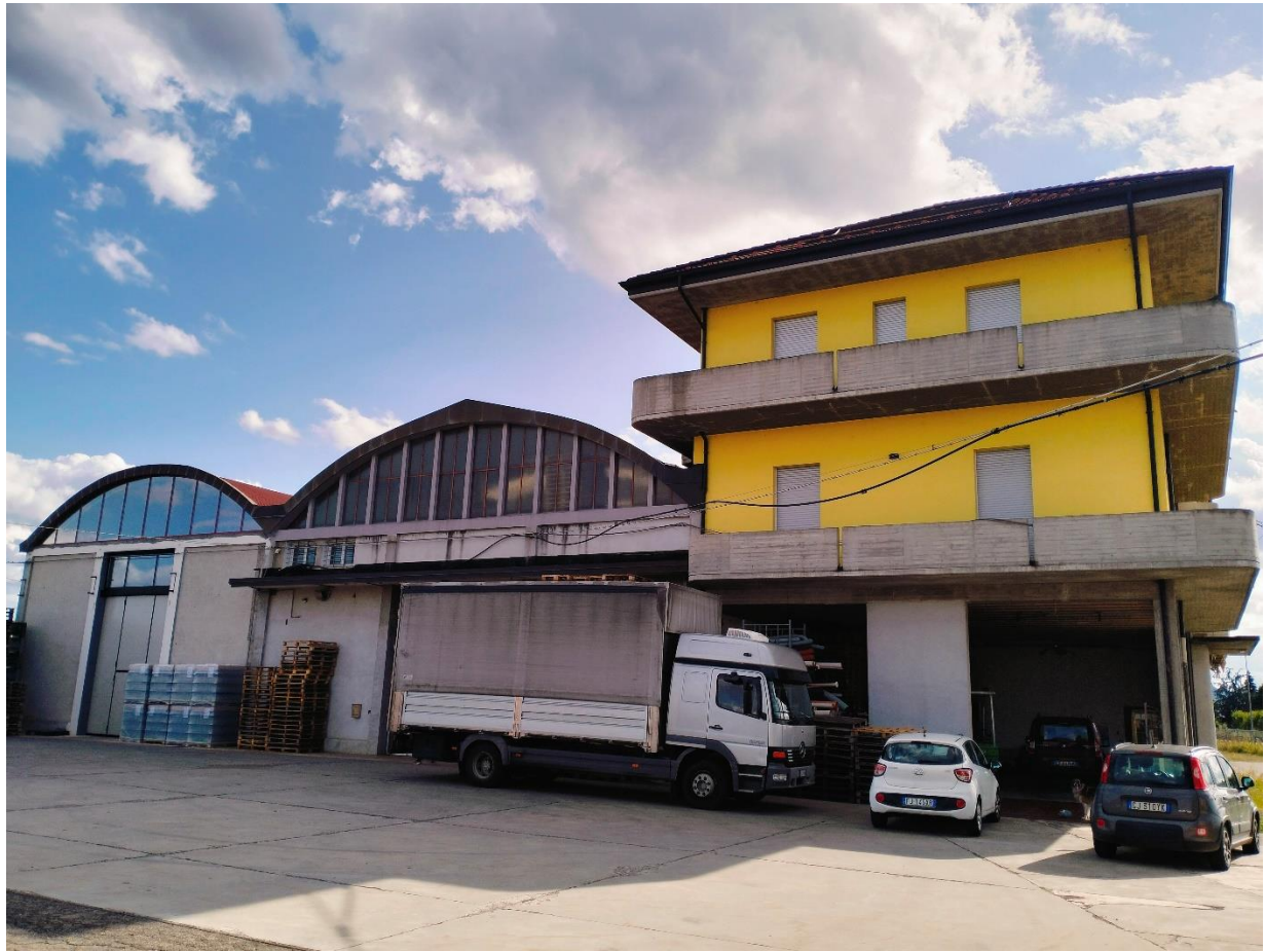
FOTO 1 – Veduta dell'edificio di Via Confine n. 10/1
