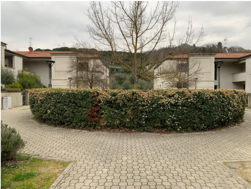
2- VEDUTA FABBRICATO E VIALETTO DI INGRESSO
