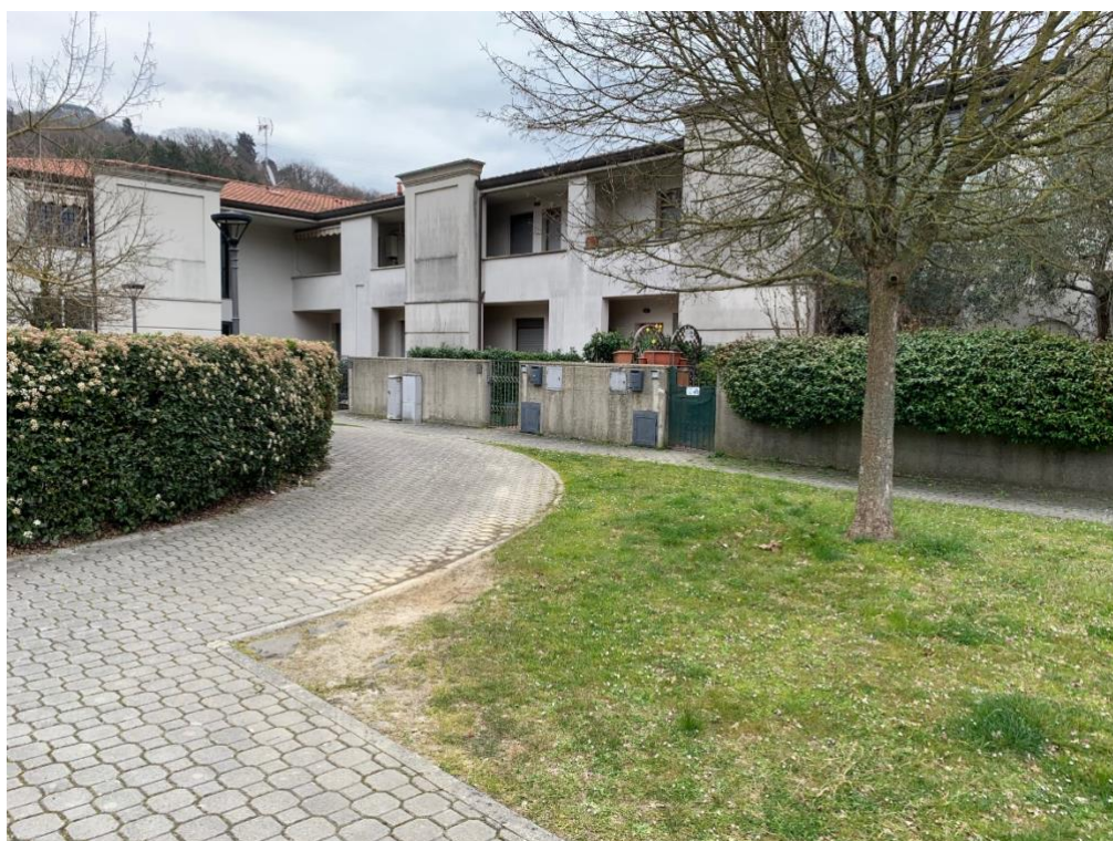
4 - VEDUTA FABBRICATO E VIALETTO DI INGRESSO
