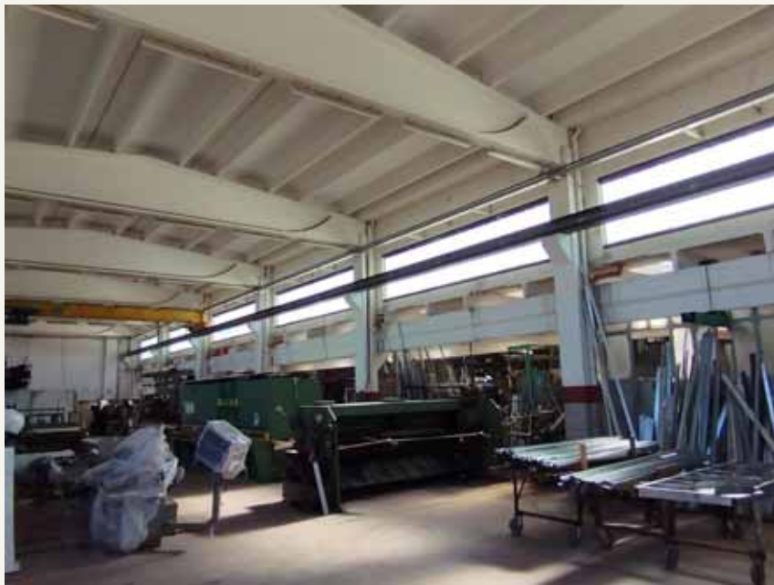
Lotto 13: p.lla 1008 sub 6 capannone officina
