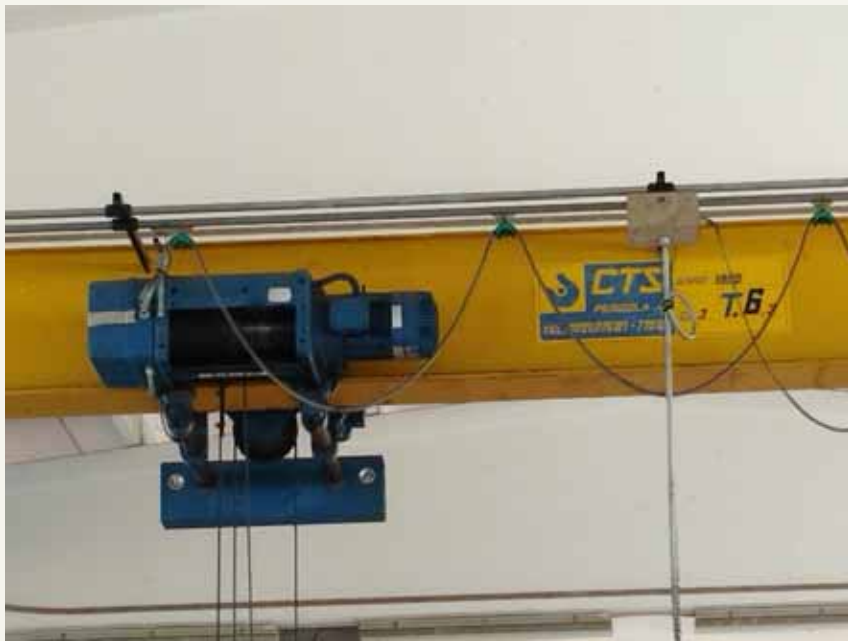
Lotto 13: p.lla 1008 sub 6 capannone officina
