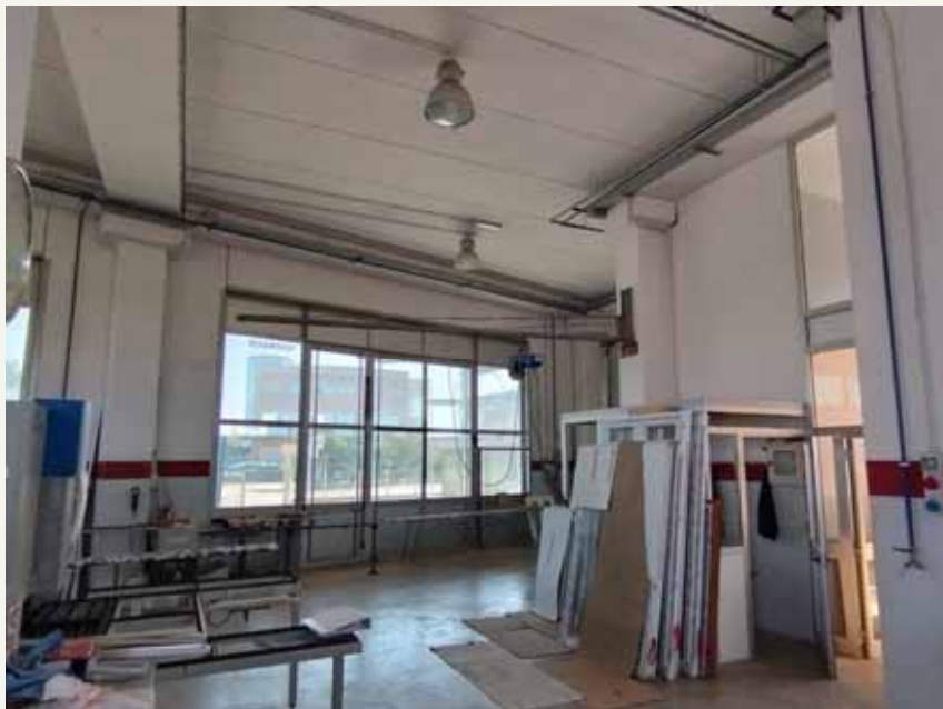
Capannone: p terra
