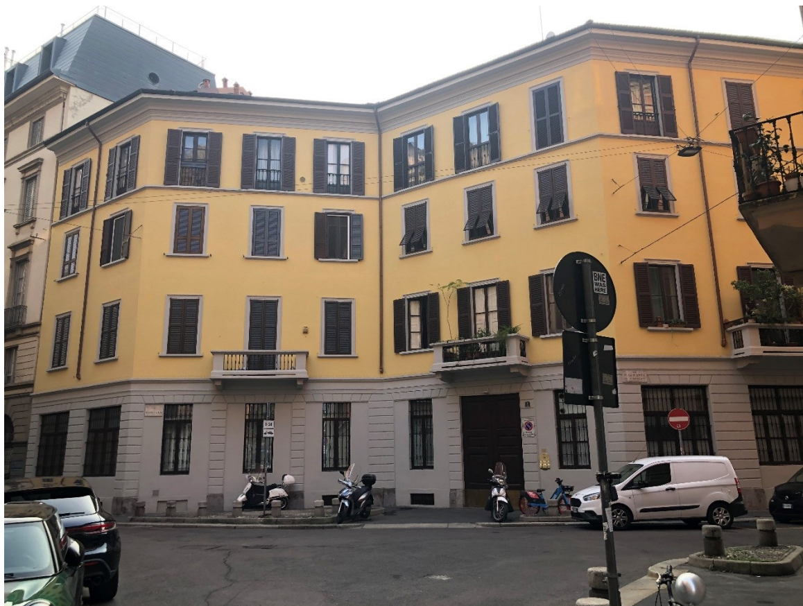
Foto 03 - Il fabbricato su via Pontida
