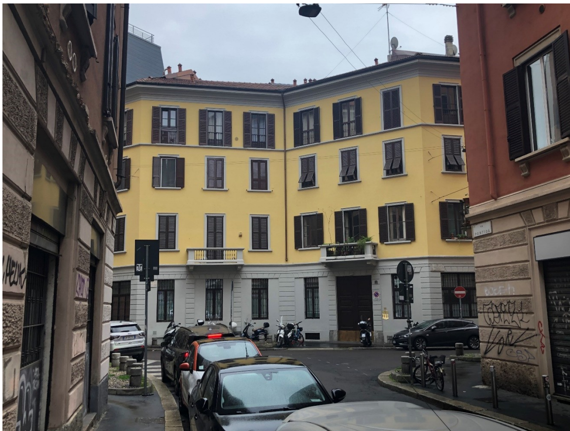
Foto 01 - Il fabbricato su via Pontida
