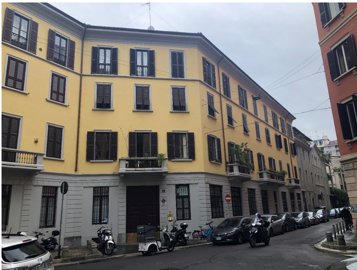
Foto 02 - Il fabbricato su via Pontida
