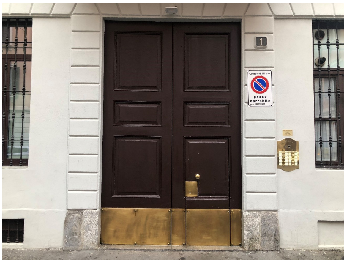
Foto 04 - Ingresso al fabbricato in via Pontida al civico 1
