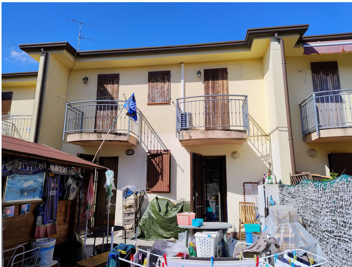
Vista fabbricato lato est (retro)
