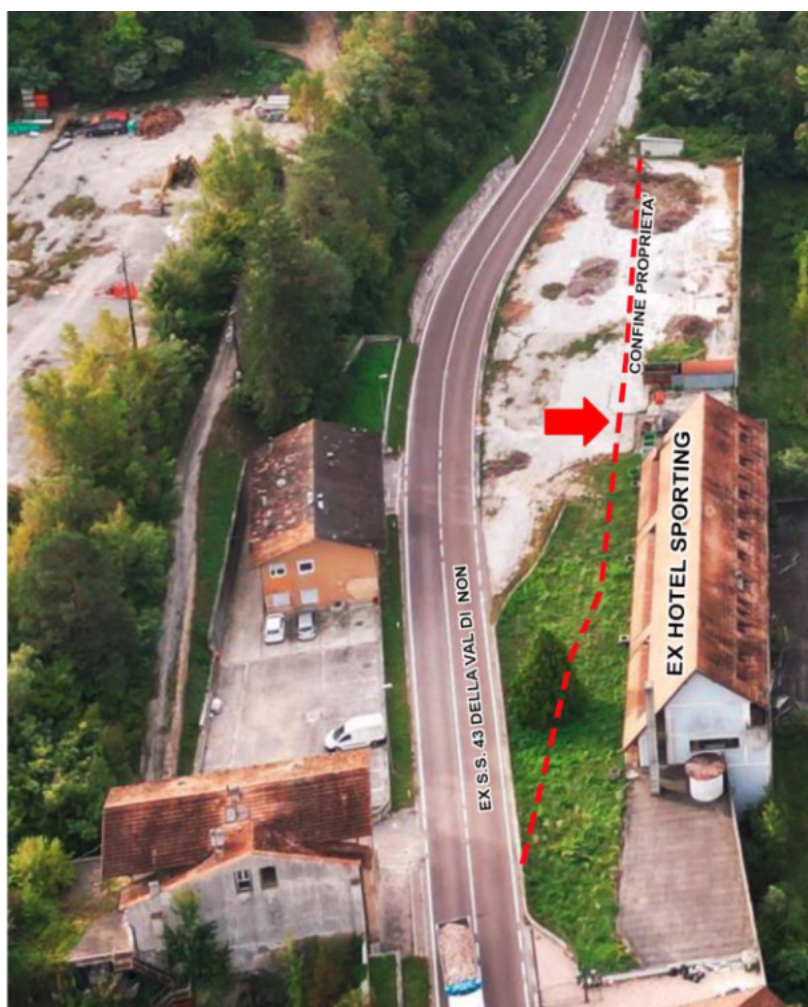
Foto aerea con cortile verso ex S.S. 43 della Val di Non di pertinenza ex "Hotel Sporting"
