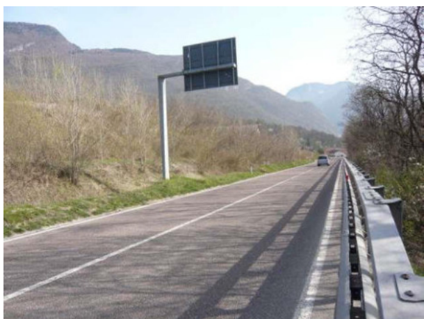
Vista rampa a confine con la strada
