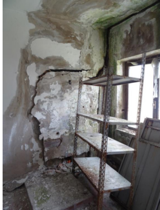
Murature contro terra
