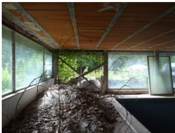
Particolare locale piscina
