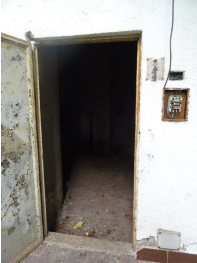
Porta ex centrale termica
