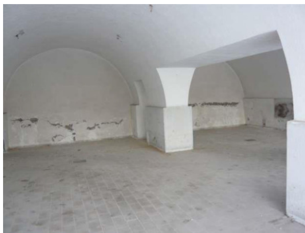
Murature contro terra
