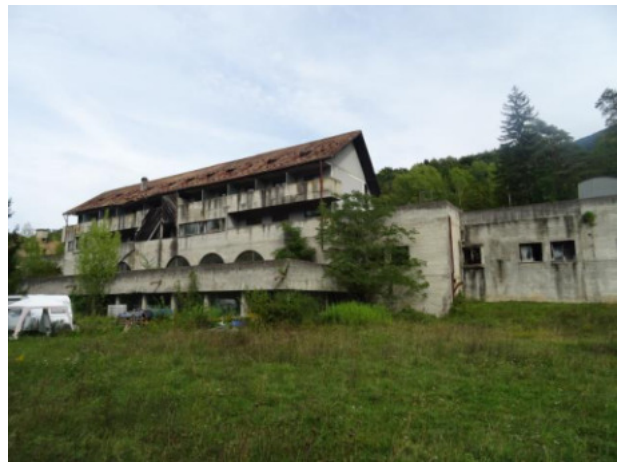
Vista da piazzale sud - ovest
