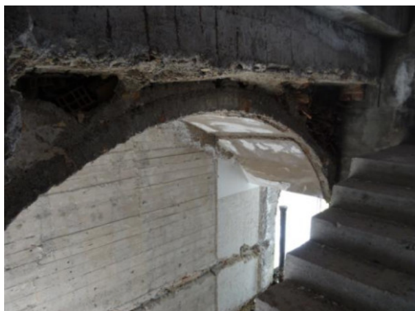
Strutture nei pressi vano scale
