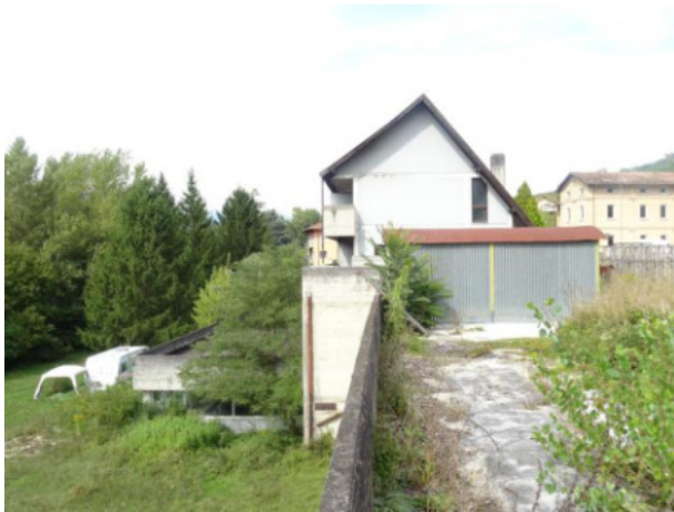
Vista da sud con muro piazzale est e ovest
