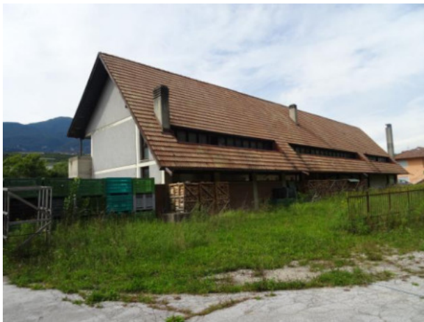
Vista da piazzale sud - est
